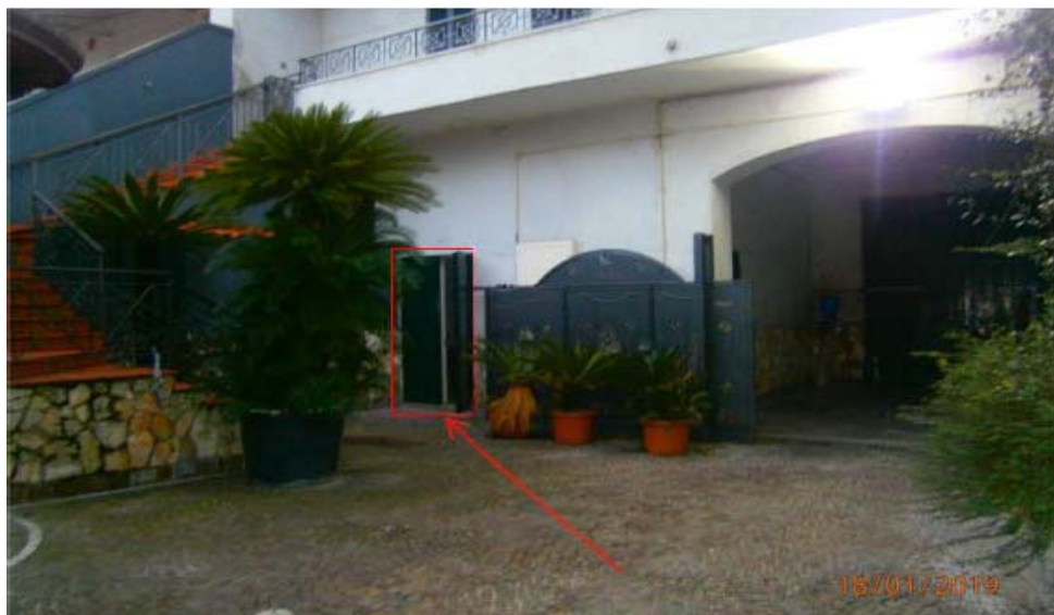
Foto n° 6 Ingresso dal Cortile Immobile P.Ila 99 Sub 2
