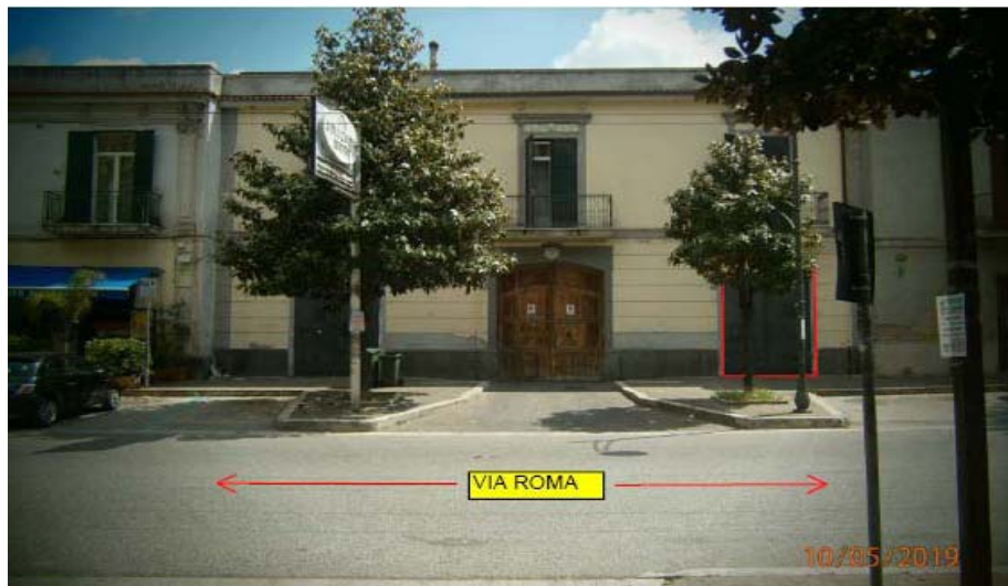
Foto n° 4 Individuazione Bene p.lla 99 sub 2 su Facciata Principale Lato Ovest
