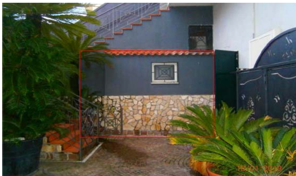
Foto n° 10 Vista Esterna WC. Immobile P.IIa 99 Sub 2
