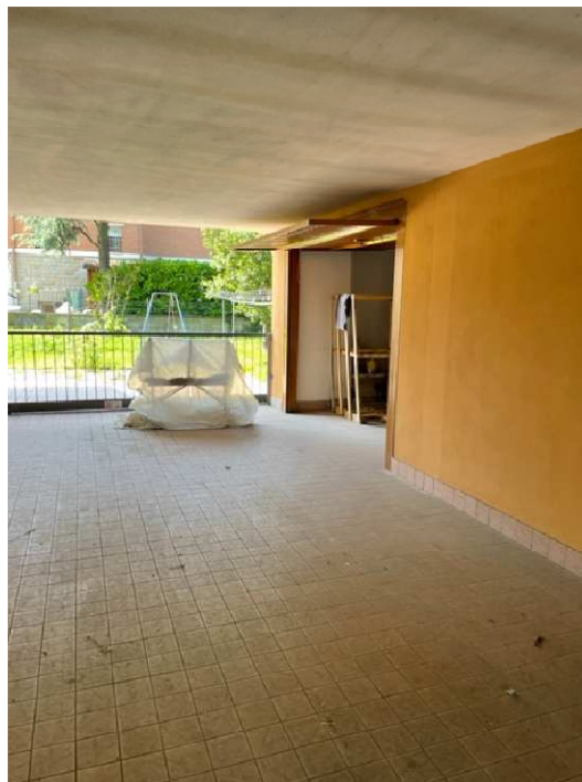
FOTO 4: Corsello di ingresso
