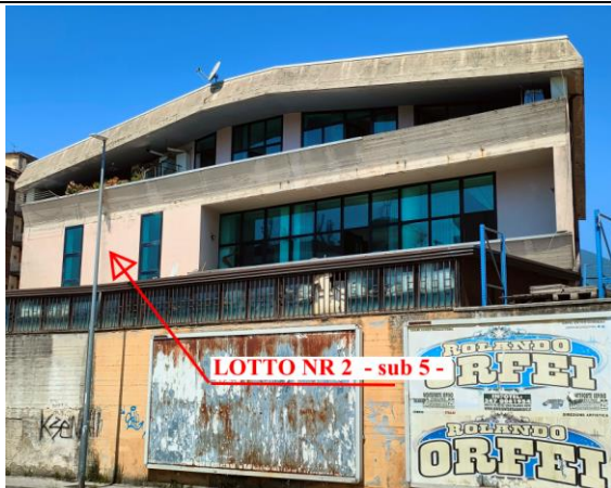
Prospetto intero edificio lungo via Vallone dei Lupi
