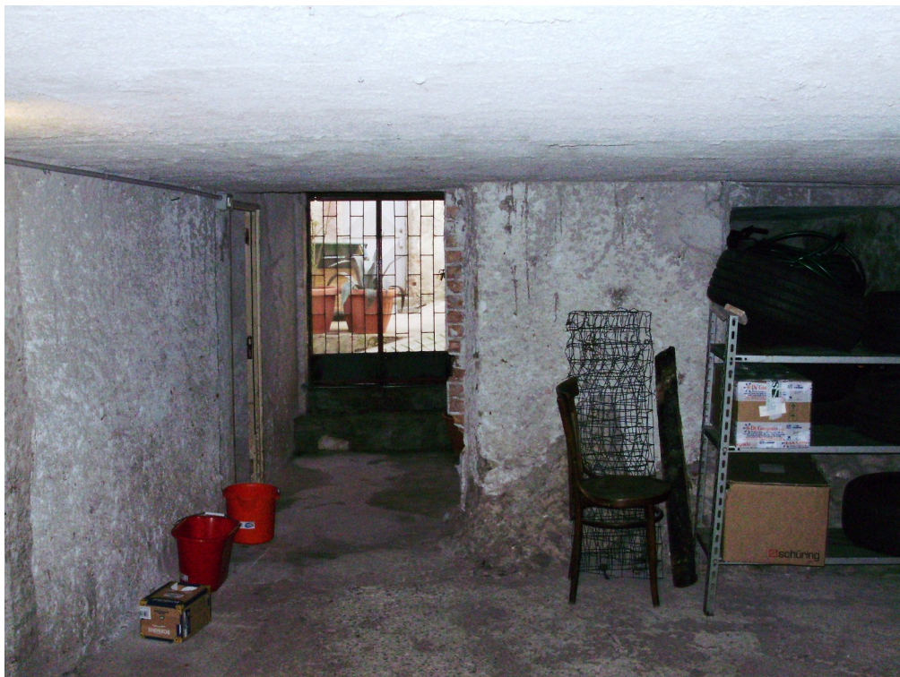
Foto n. 7 – locale al piano terra
