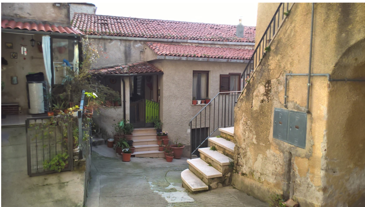
Foto n. 1 – prospetto nord sul lato di ingresso all'abitazione
