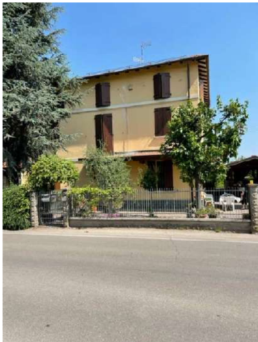
FOTO 1: Vista Prospettica abitazione
