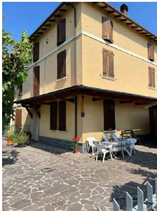
FOTO 4: Vista Prospettica abitazione
