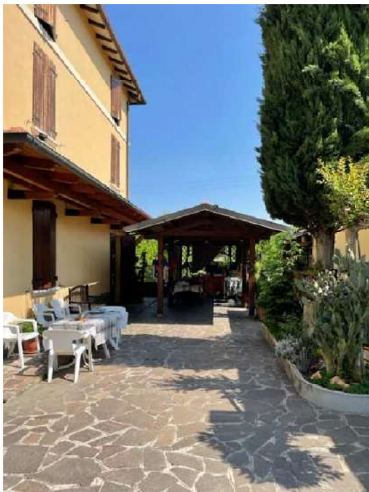
FOTO 3: Vista Prospettica abitazione
