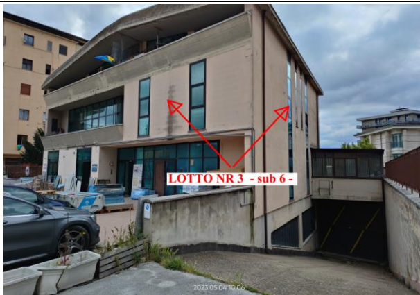
Prospetto intero edificio lungo via C. Renzi
