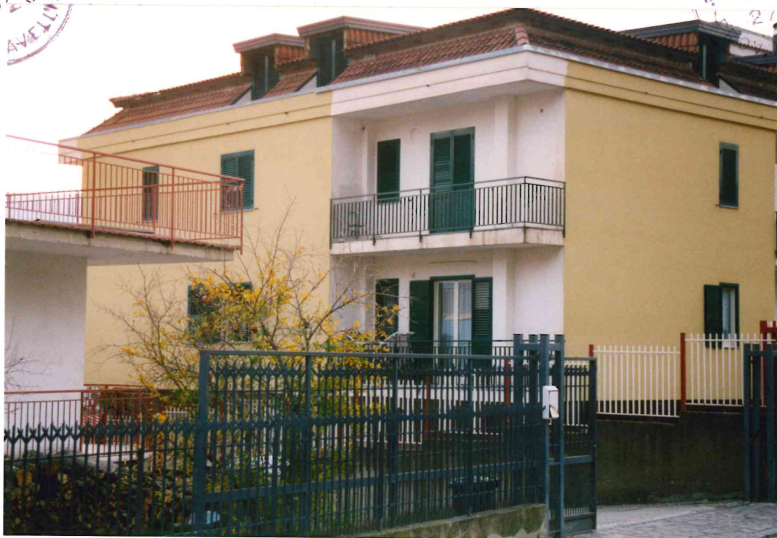
FOTO: Prospetto laterale est su area pertinenziale.
