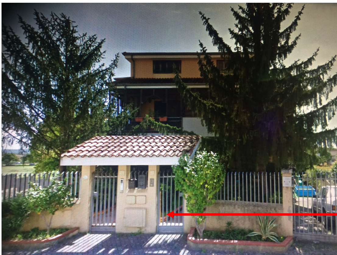
FOTO foglio 34, particella 364 - SUB 1
