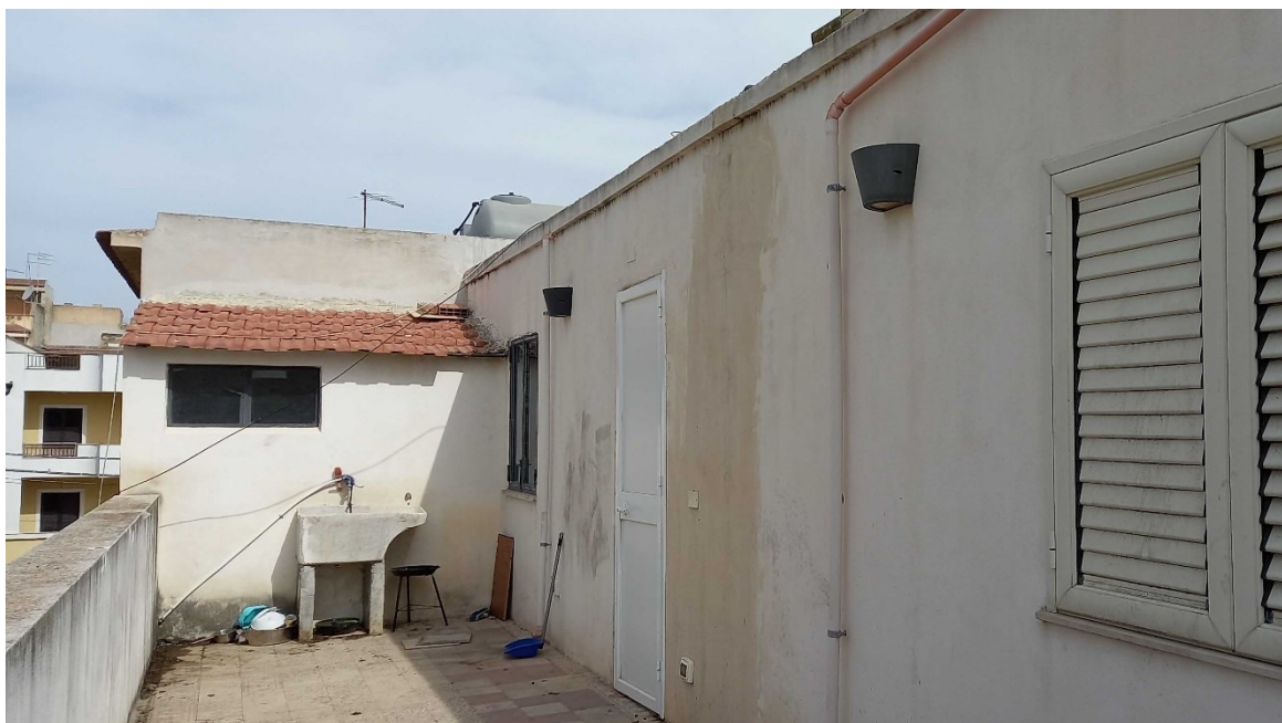
Foto 15 – Immobile “1A” – Terrazza al II P
