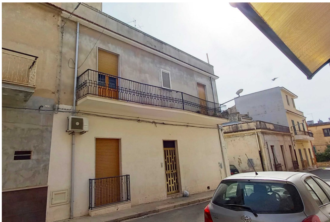
Foto 2 – Immobilità “1A” – Prospetto principale di via Cagliari
