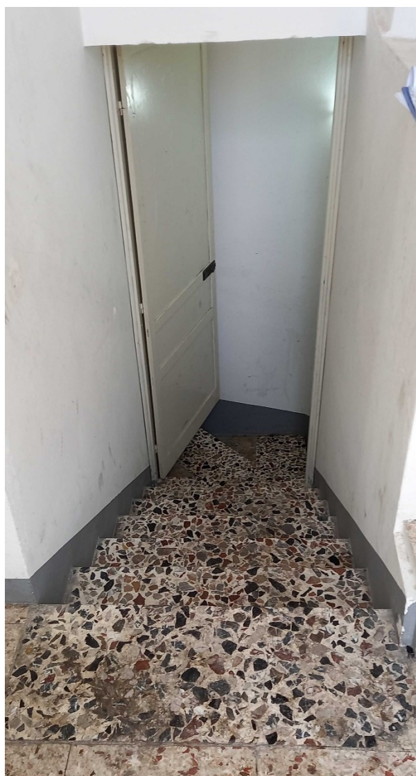
Foto 12 – Immobile “1A” – Vano scala che conduce alla terrazza
