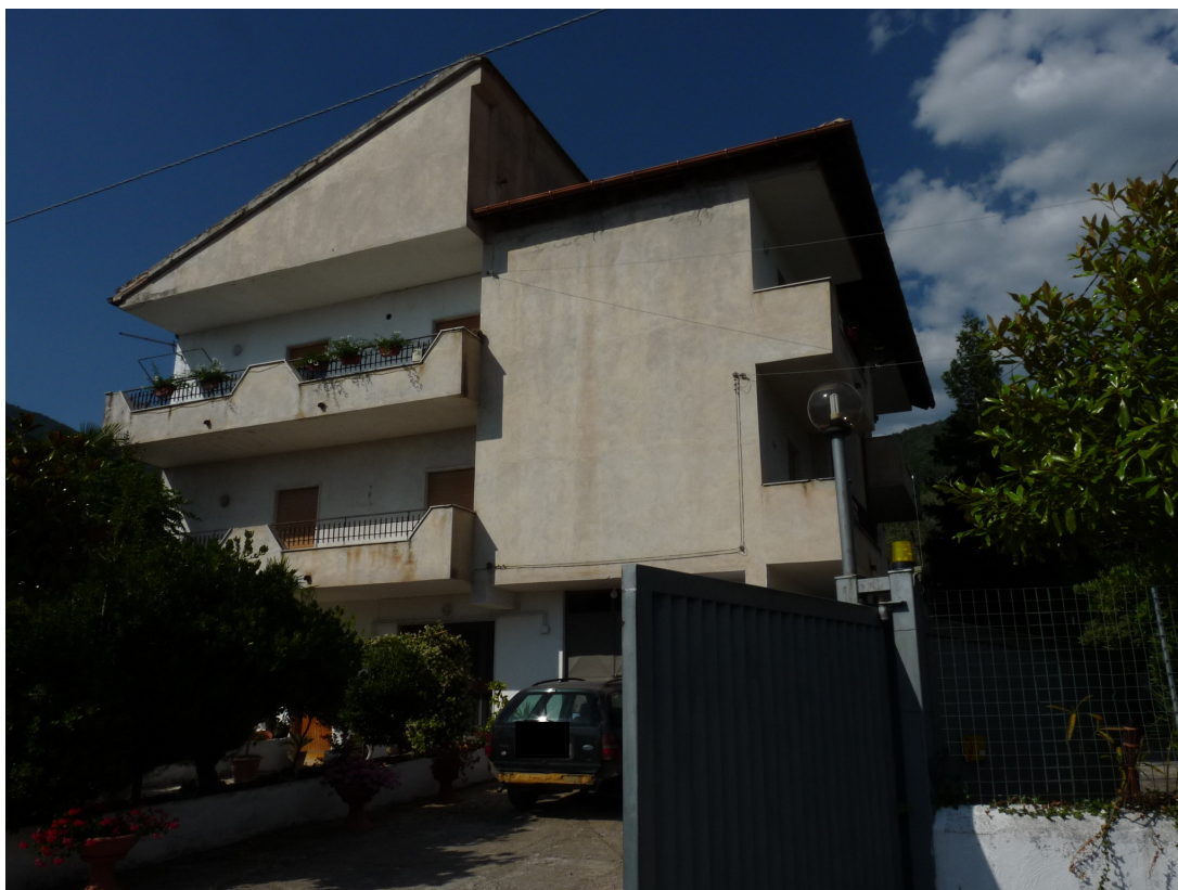
Foto 1: Vista prospetto principale (fronte sud-ovest) dal varco di ingresso al cortile comune
