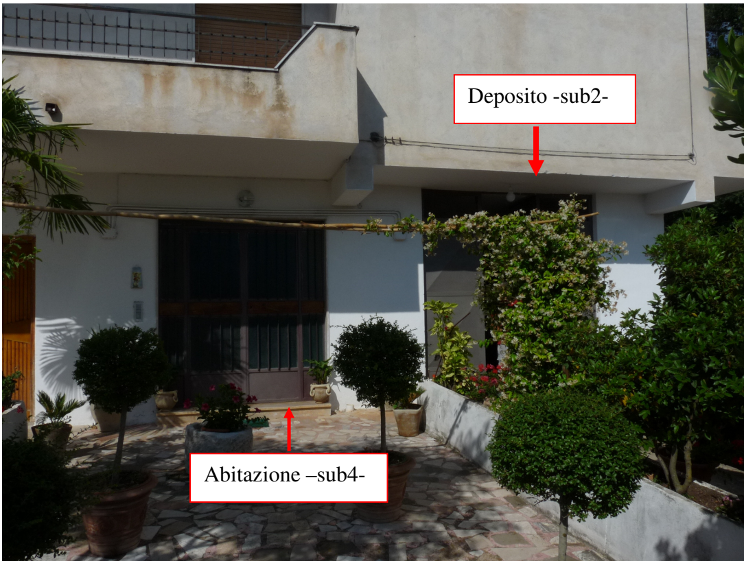
Foto 4: Particolare ingressi del fabbricato (prospetto sud- ovest) dal cortile comune
