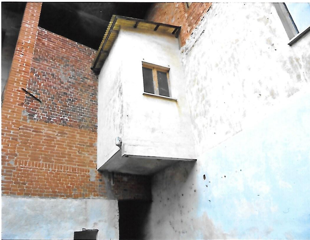
Foto 14 – Bagno Mapp.296 sub.6 visto da esterno
