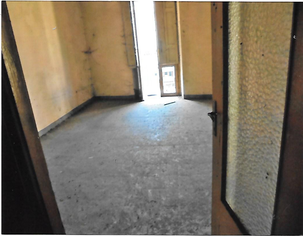
Foto 17- Interno Mappale 296 sub.6
