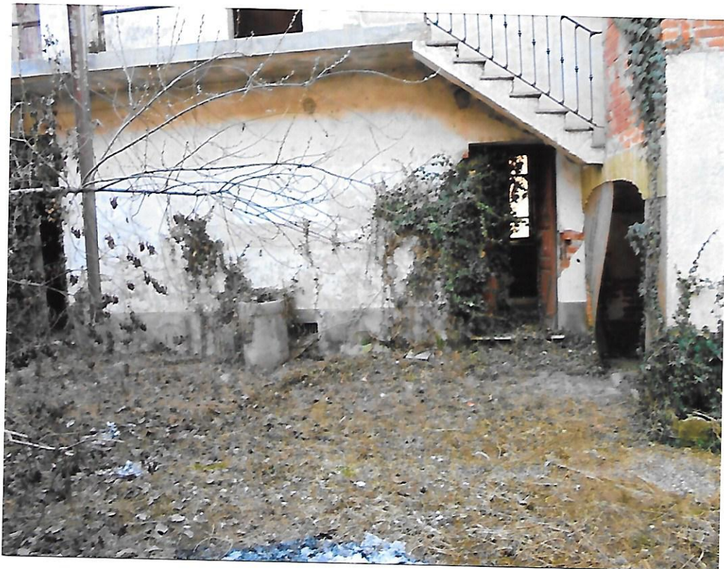
Foto 4 – Unico ingresso da cortile
