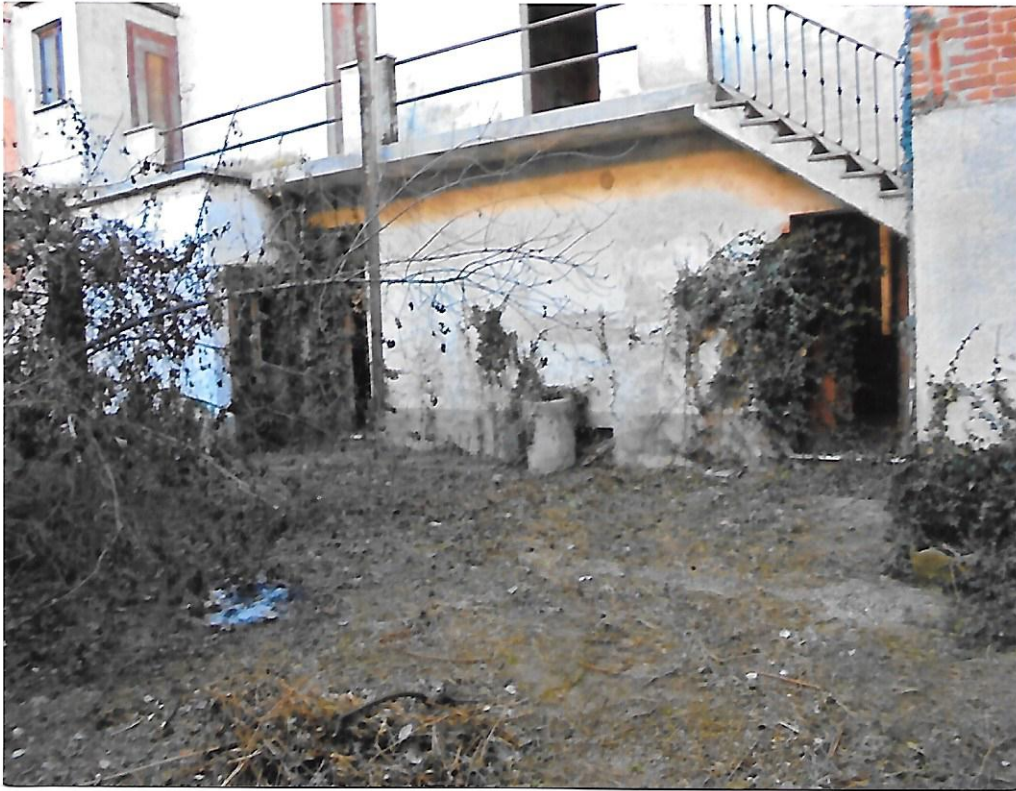
Foto 5- Fronte su cortile mappale 296 sub.5
