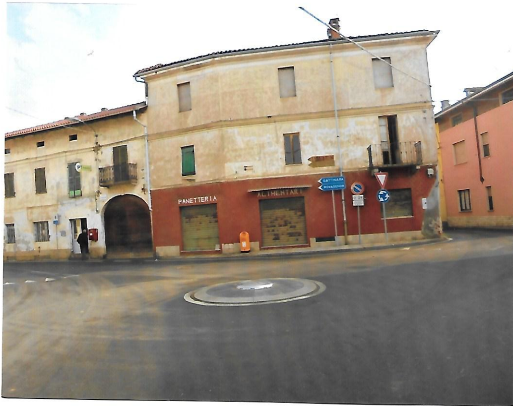
Foto 1- Fronte principale su Piazza Libertà
