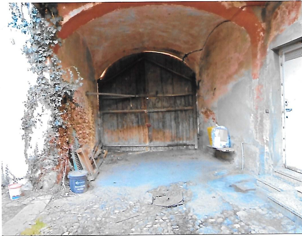
Foto 7- Androne carraio visto da interno cortile
