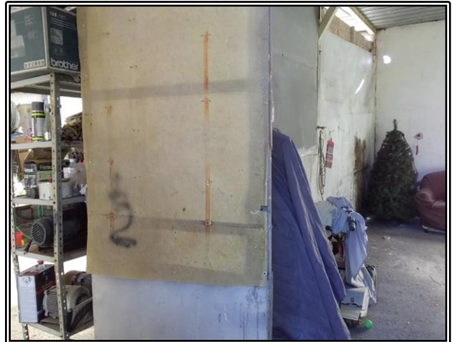
Figura 39 collegamento tra tettoia1 e tettoia2
