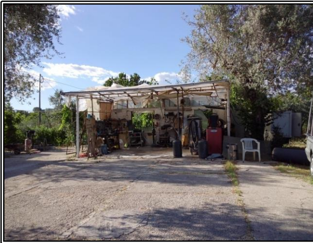
Figura 43 tettoia realizzata con materiali precari
