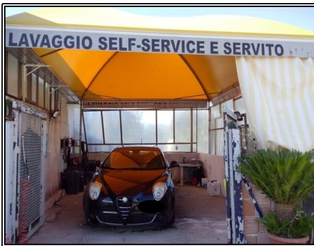
Figura 30 area coperta con tendostruttura
