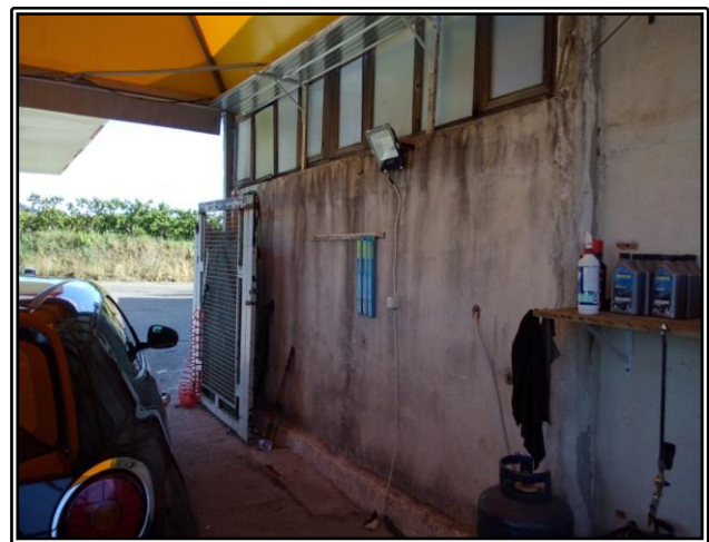
Figura 31 vista interna della tendostruttura
