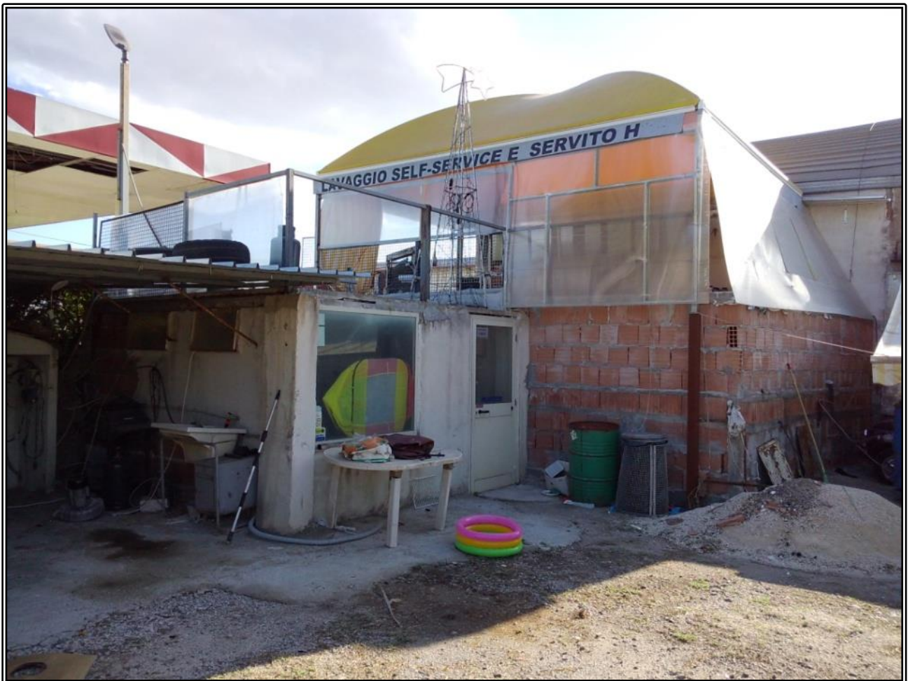
Figura 42 locale basso in muratura realizzato a ridosso del piazzale superiore
