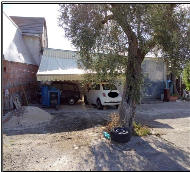
Figura 34 vista esterna delle tettoie
