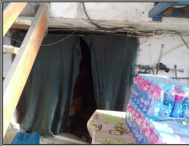
Figura 36 particolare interno tettoia1
