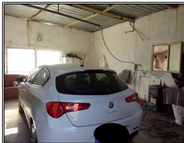
Figura 40 particolare interno tettoia2
