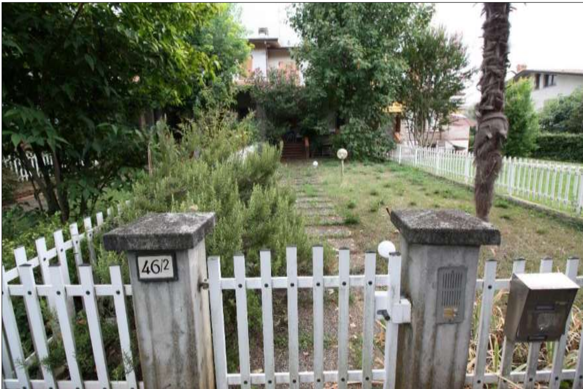
Foto n° 1: Prospetto ovest del fabbricato e dell'area cortiliva.
