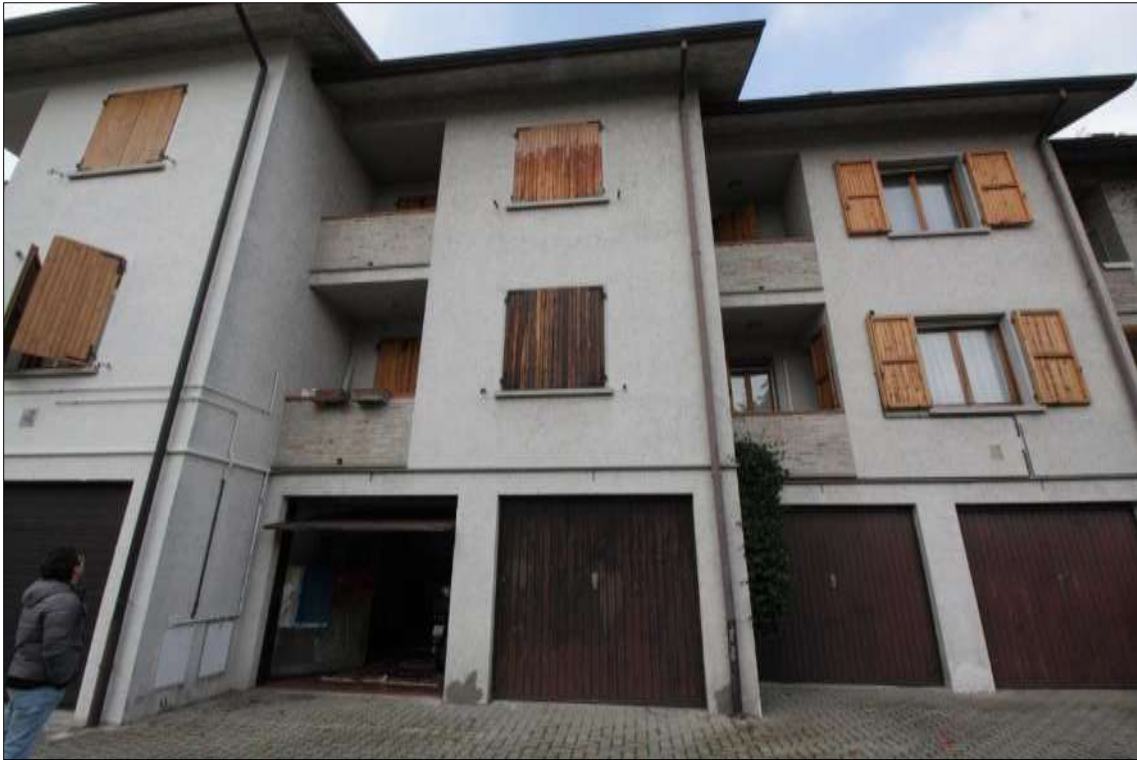
Foto n° 2: Prospetto est del fabbricato con ingresso garages.
