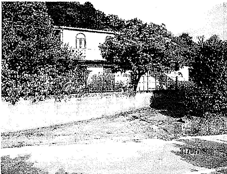
Foto n. 1 – Vista del fabbricato dalla strada statale 109
