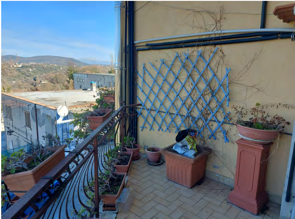
FOTO N. 13-14- Vista dei terrazzi al P1 dell'appartamento di civile abitazione sito in Comune di Poggio Nativo, via Farense snc, individuato al NCEU del detto comune al fg. 5 part. n. 167 sub 19, PT-1-2 categoria A/2 vani 11, R.C. € 766,94
