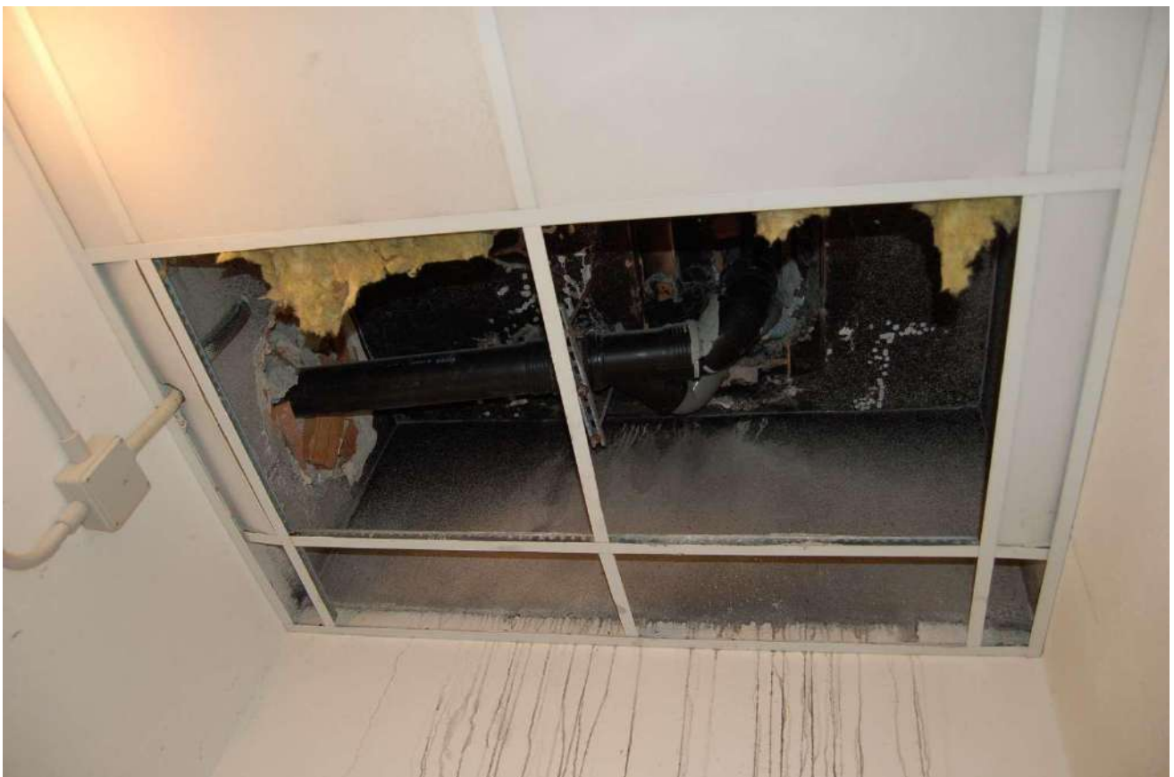
Foto 21 - Controsoffitto cantina sub.27
