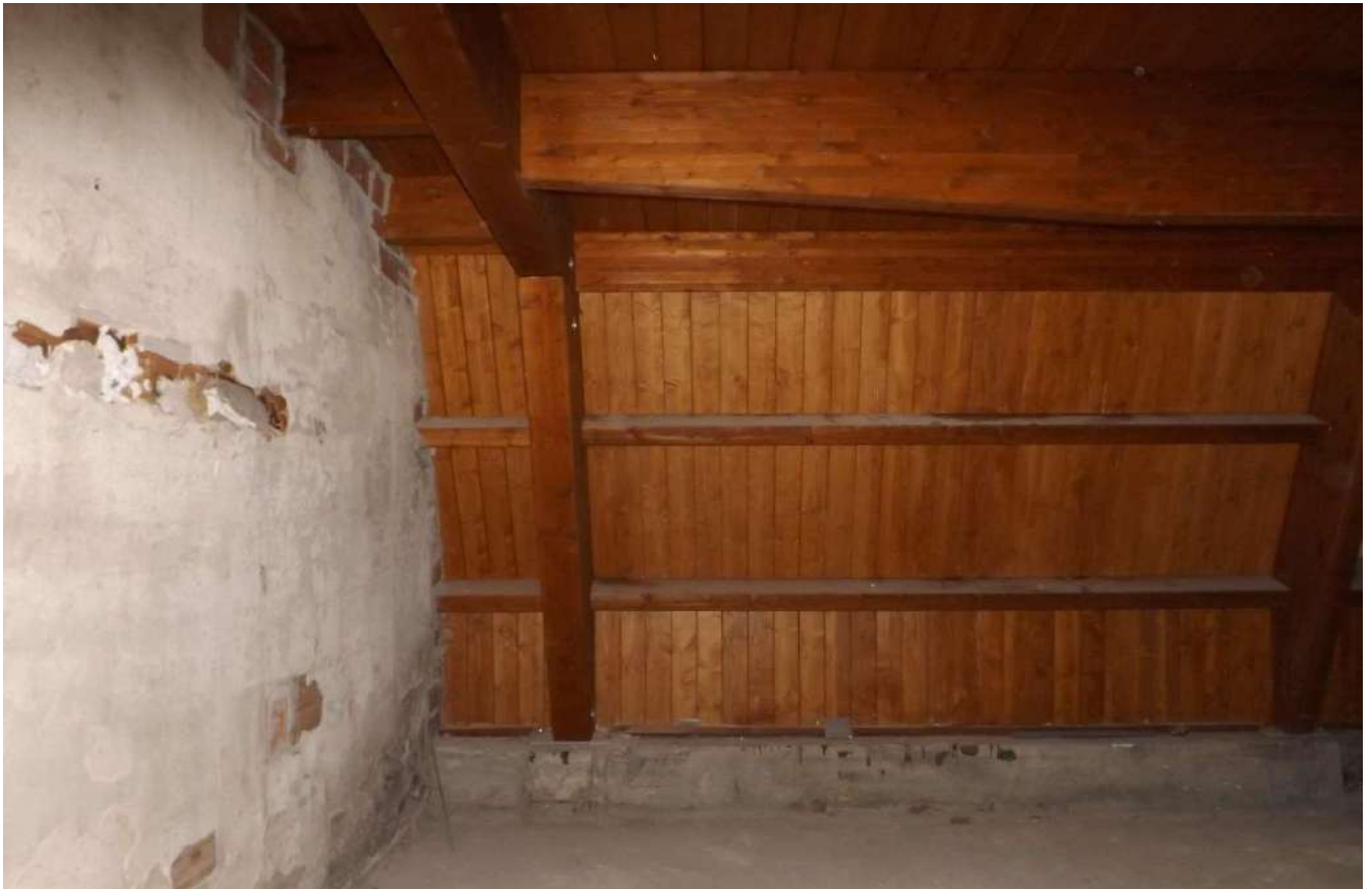
Foto 57 - - Appartamenti fg 26 part. 268 sub.70-711
