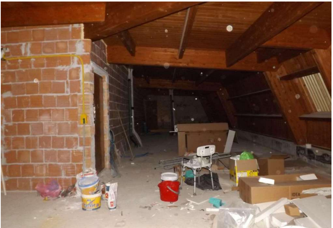
Foto 60 - Appartamenti fg 26 part. 268 sub.70-71
