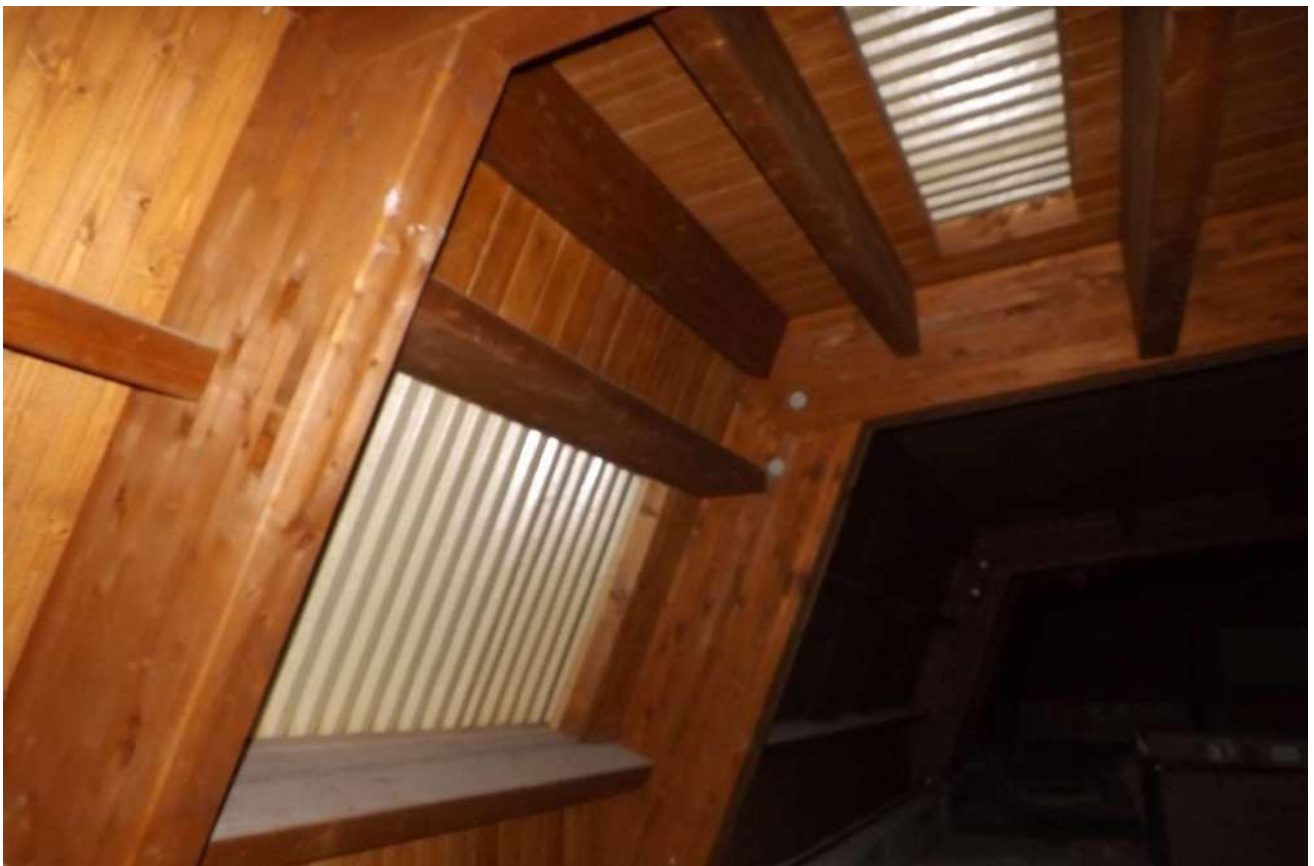
Foto 58 - Appartamenti fg 26 part. 268 sub.70-71
