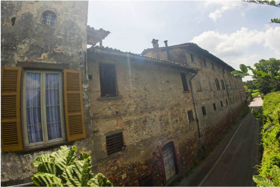
Facciata lungo la via Villa Gromo, con intonaco e muri in mattoni e sassi
