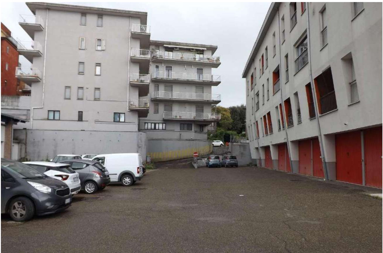
Foto 8 - Accesso da Via Dante Alighieri
