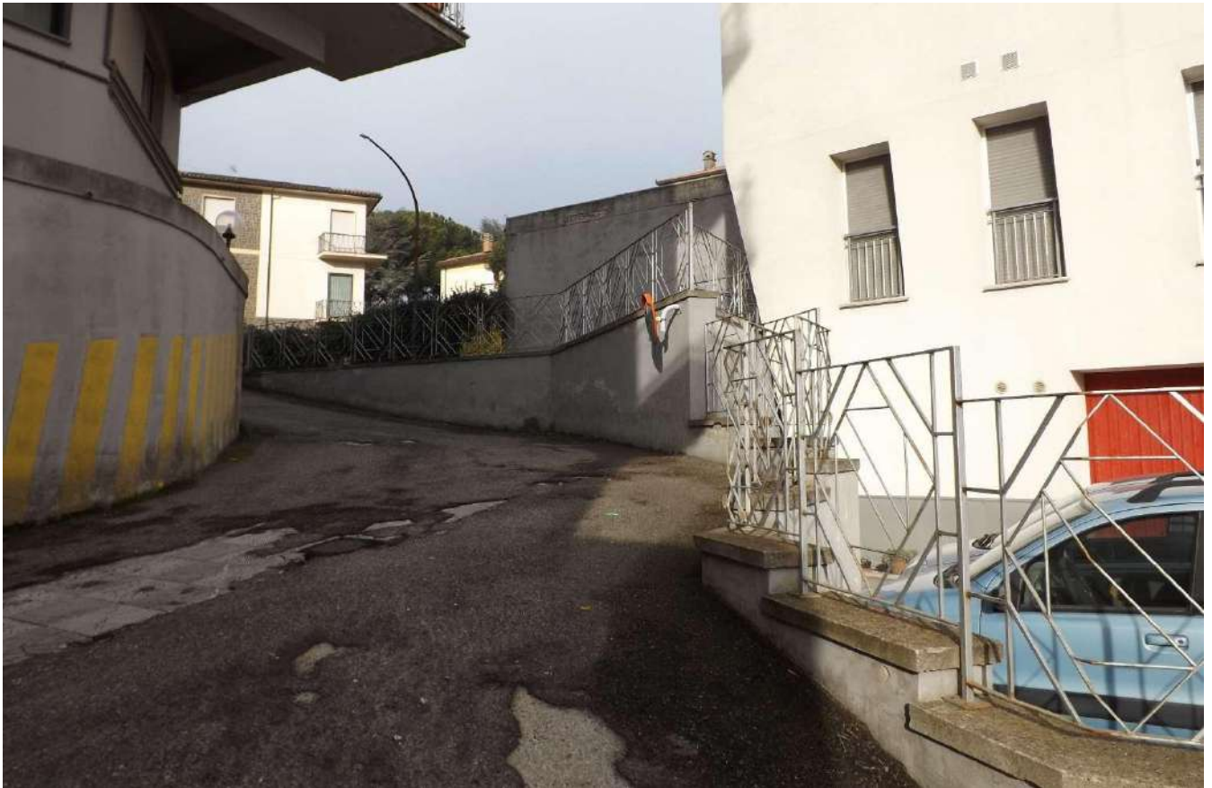
Foto 9 - Dettaglio rampa accesso da Via Dante Alighieri
