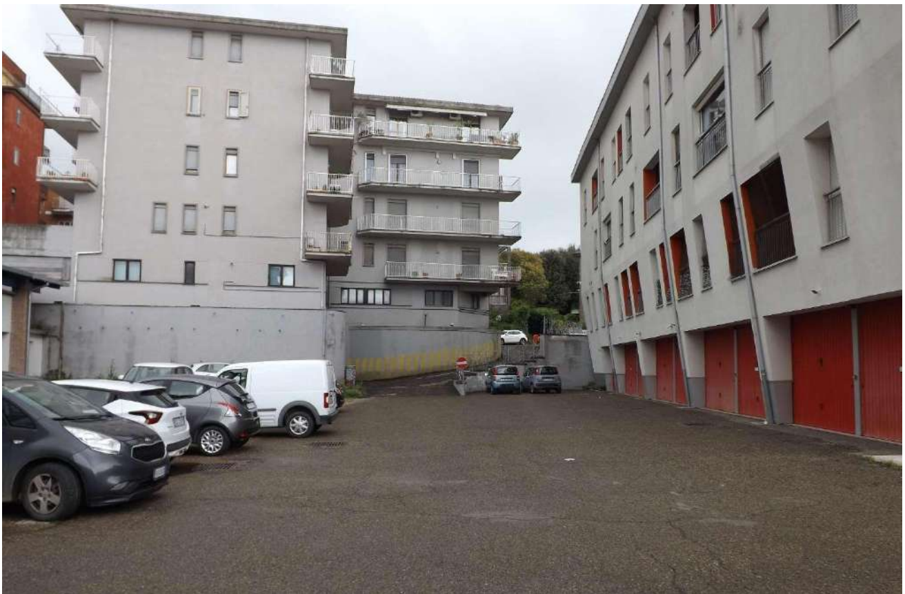
Foto 10 - Vista della corte comune adibita a parcheggio
