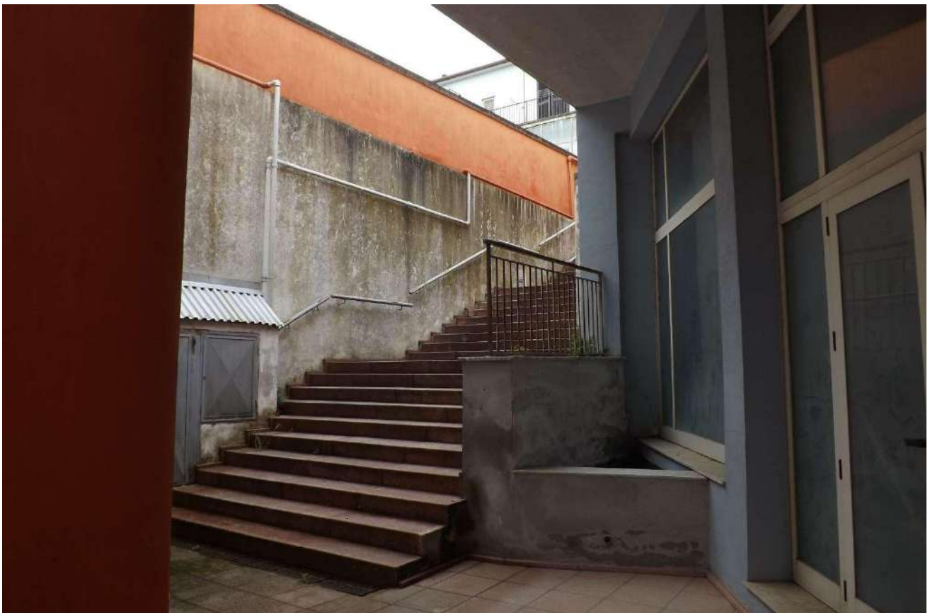
Foto 6 – Accesso da Via Tagliamento
