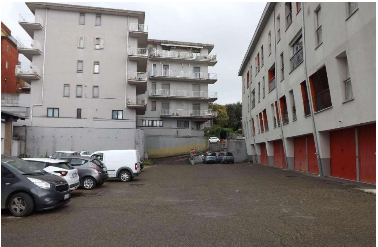
Foto 10 - Vista della corte comune adibita a parcheggio
