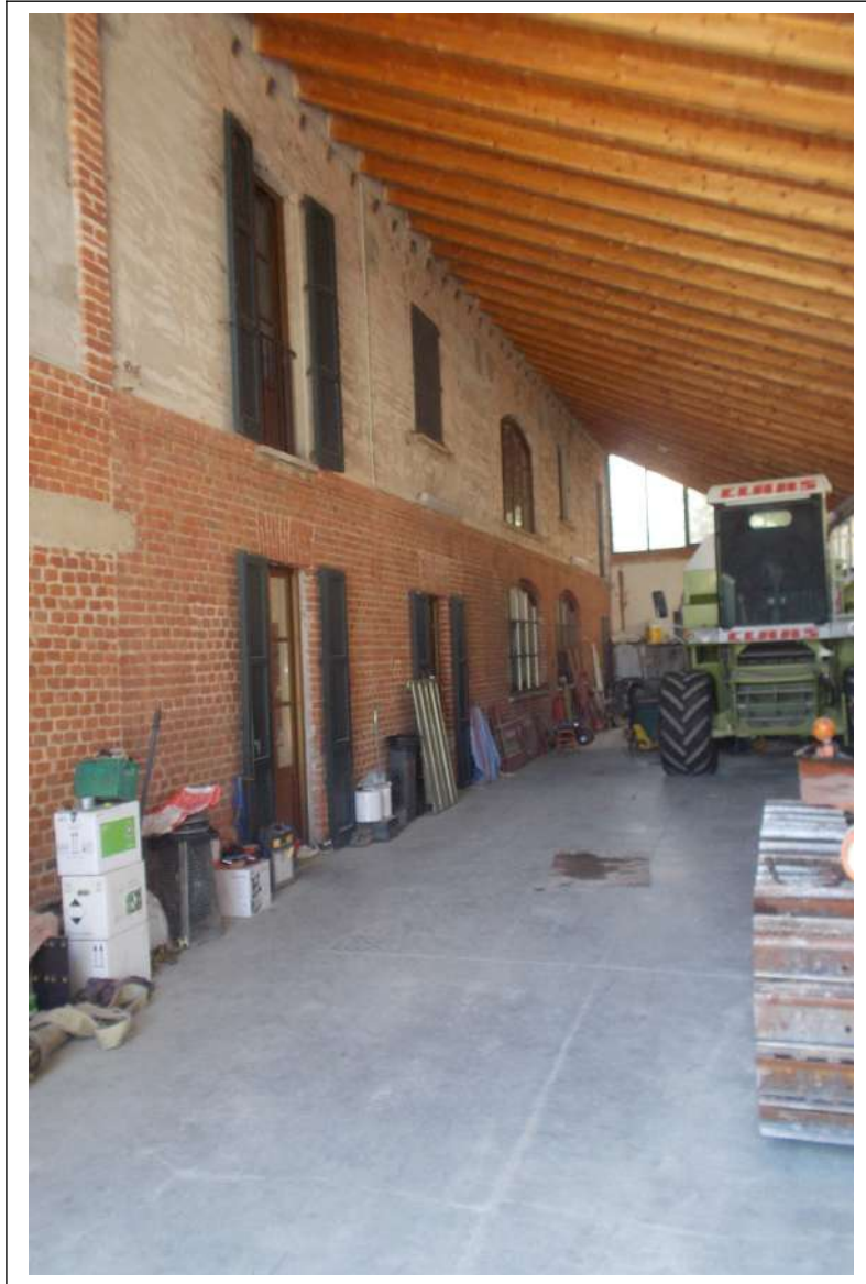
Fotografia n. 23 = LOTTO 1 - Corpo D - Vista interna
