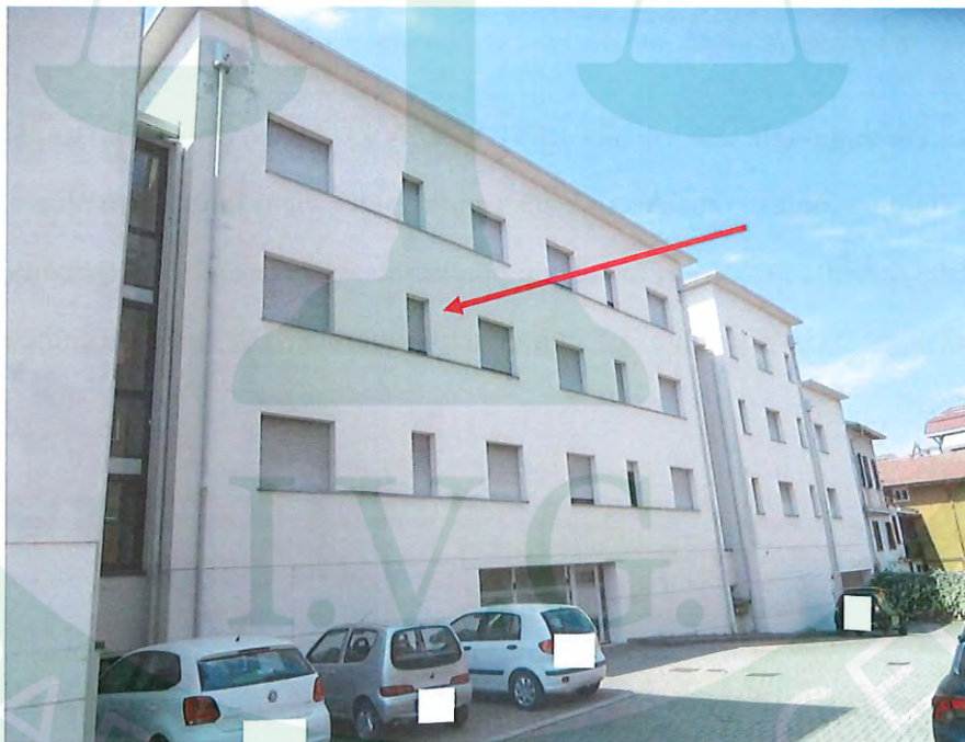
Vista del fabbricato dal cortile interno carrabile posto sul lato nord . Al secondo piano è situato l'appartamento oggetto della presente perizia
