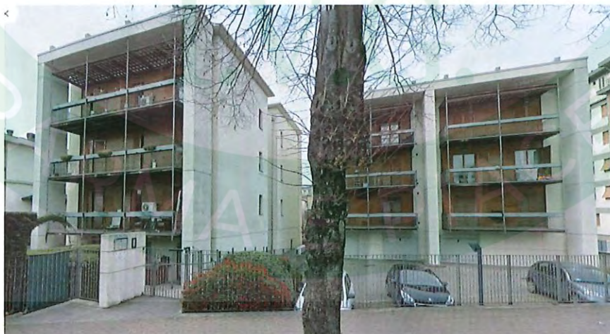
Vista del complesso immobiliare da est su via Roma
