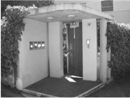
Pensilina d'ingresso alla corte comune dalla strada pubblica
