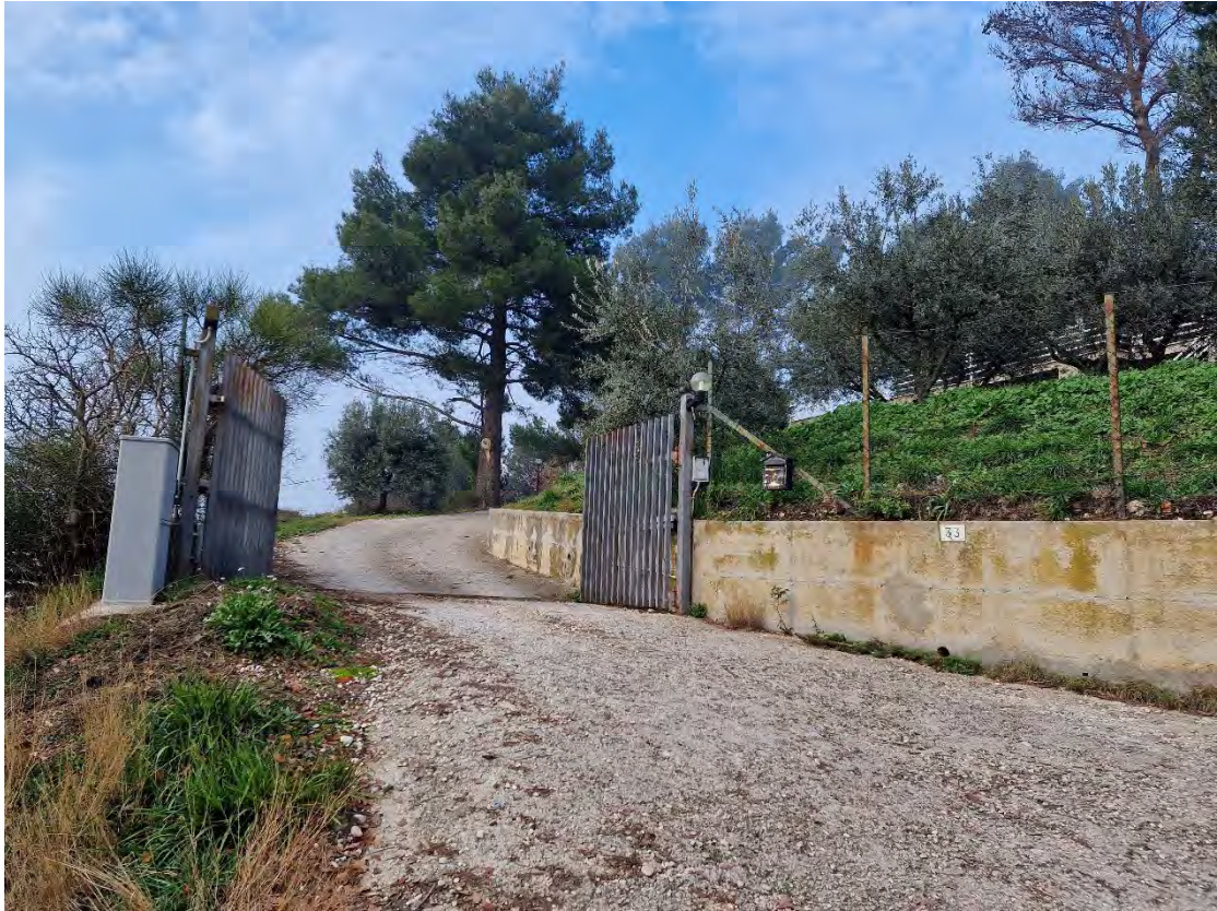
FOTO INGRESSO ALLA PROPRIETA'
