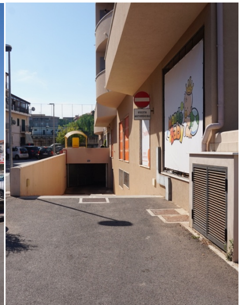
Accesso da rampa carrabile (sub 43)
