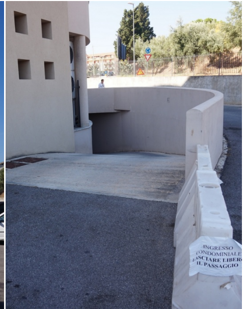
Accesso da rampa carrabile (sub 45)
