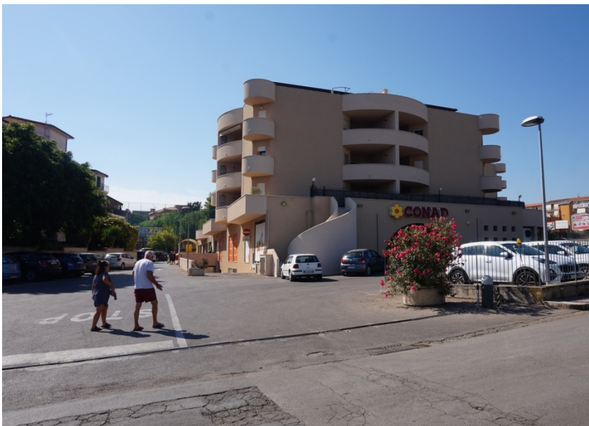
Prospetto su viale Italia
