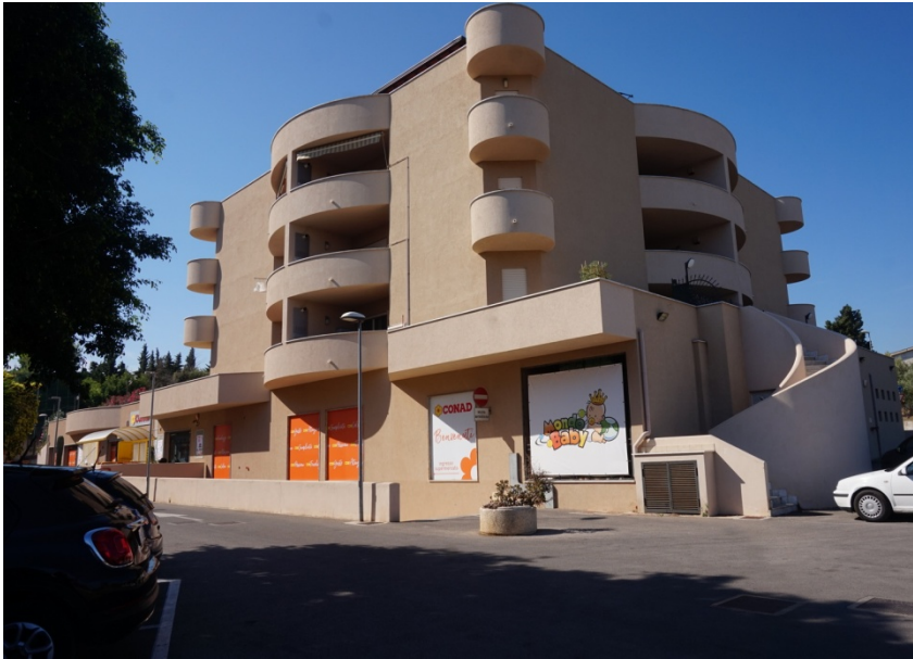
Veduta del fabbricato da area esterna comune
