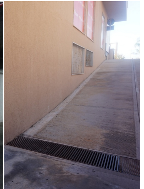
rampa carrabile (sub 43)
