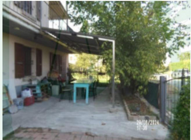
Realizzazione di una tettoia con struttura metallica al piano primo, sopra alla terrazza;
