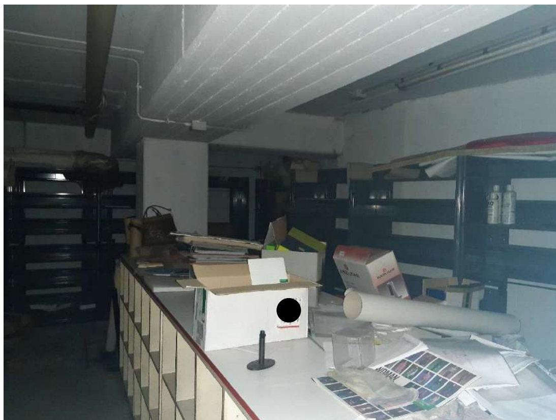
Foto 7 Particolare interno Magazzino
