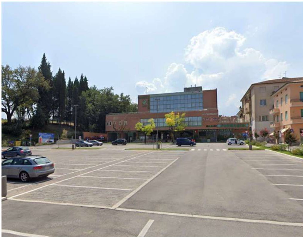
Foto 1 particolare esterno Centro Commerciale
