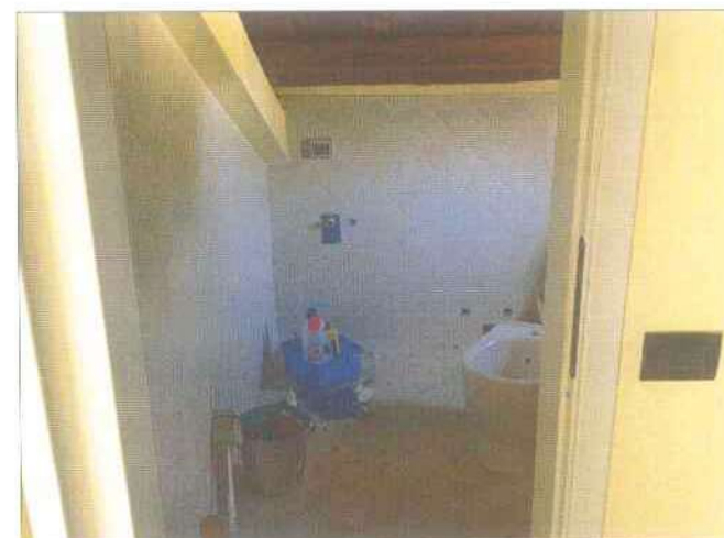
Foto 5 Interni piano mansarda
