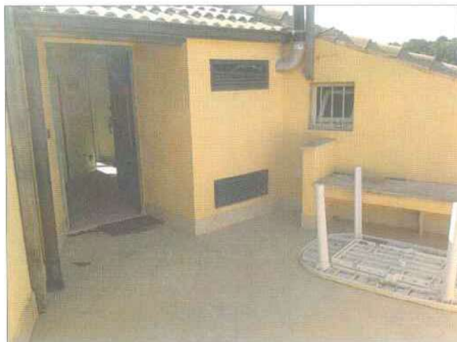
Foto 2 ingresso piano mansarda
