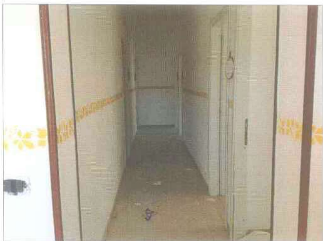
Foto 11 interni piano terra
