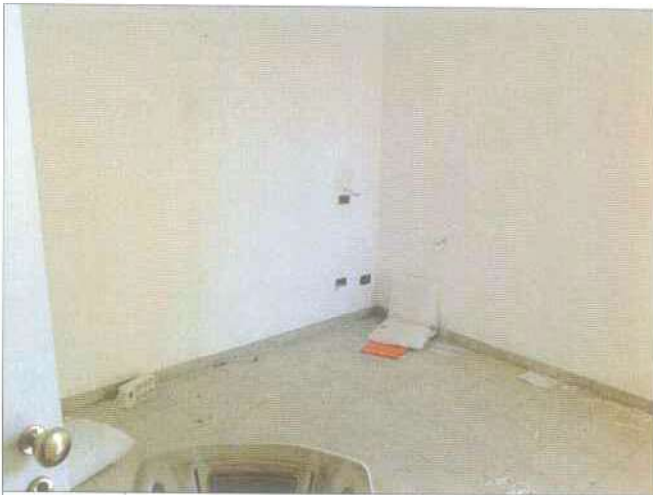
Foto 19 interni piano terra
