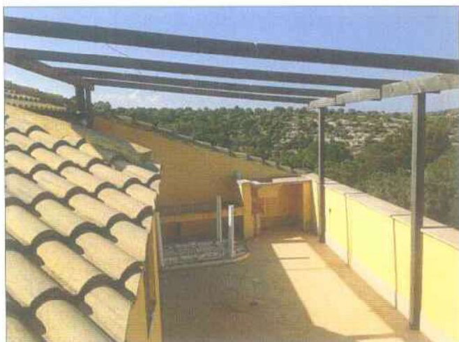
Foto 1 terrazza piano mansarda
