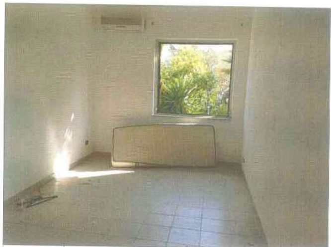
Foto 18 interni piano terra
