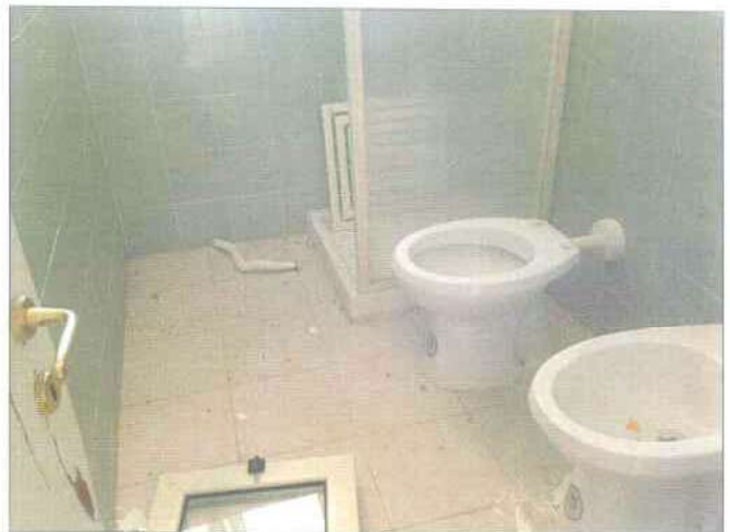
Foto 22 interni piano terra
