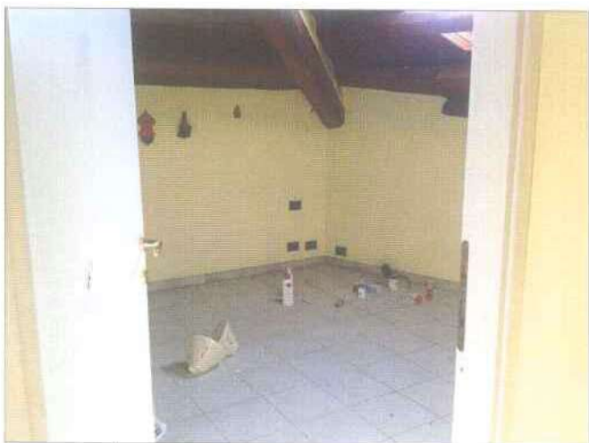
Foto 7 Interni piano mansarda
