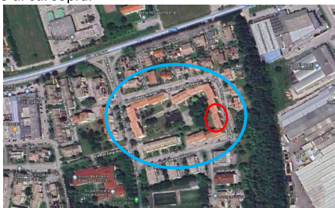
Figura 1 – vista dall'alto del super-condominio (cerchiato in 'azzurro') in cui gli immobili pignorati insistono (immagine satellitare - google maps 2024) cerchiato in 'rosso' il corpo al civico n. 15 di via Turati
