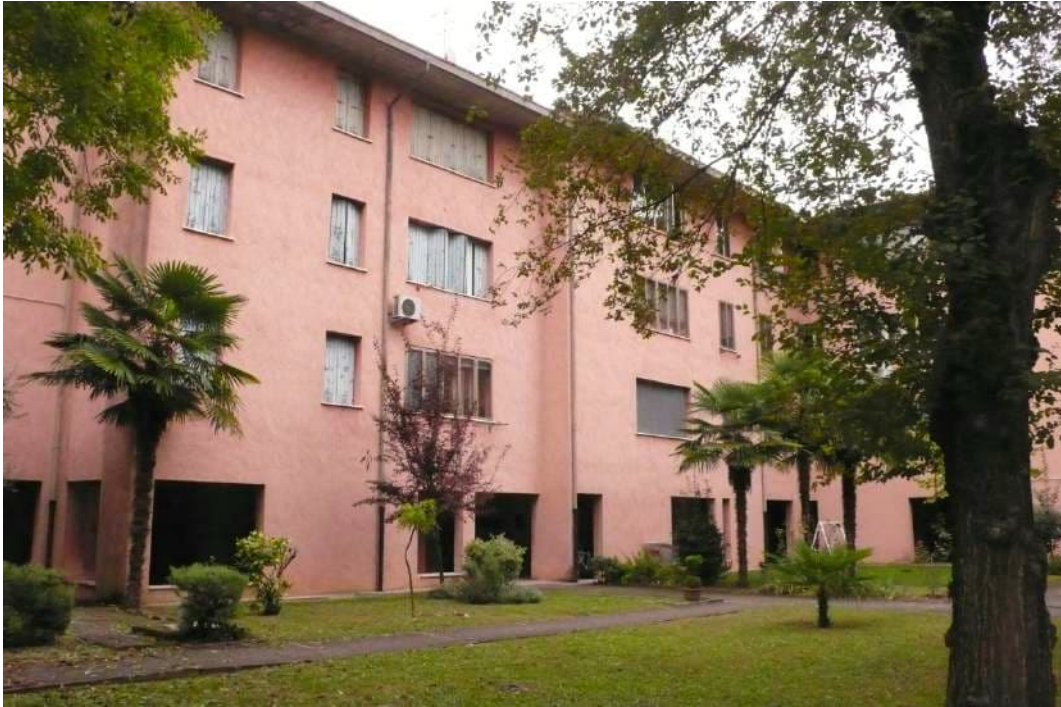
Figura n. 2 – stabile al civico n. 15 di via Turati – al P.3 l'appartamento pignorato
