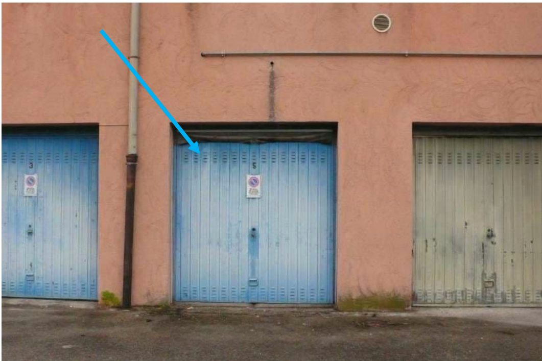
Figura n. 3 – stabile al civico n. 15 di via Turati – al P.T l'autorimessa pignorata
