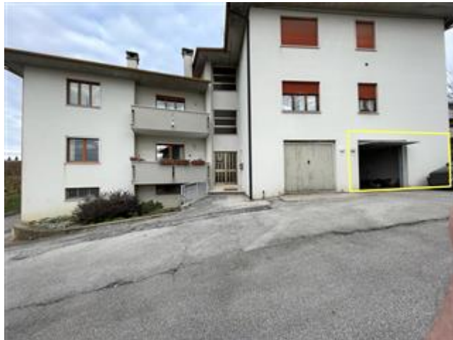
Vista esterna da sud (contorni indicativi sull'autorimessa sub. 6).
