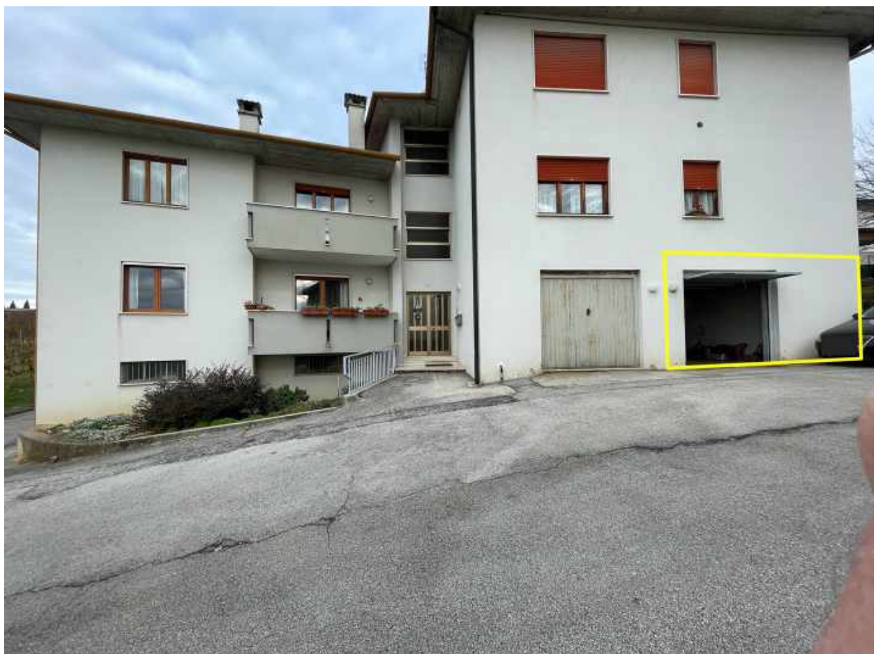
Foto 2. Vista esterna da sud (contorni indicativi sull'autorimessa sub. 6).
