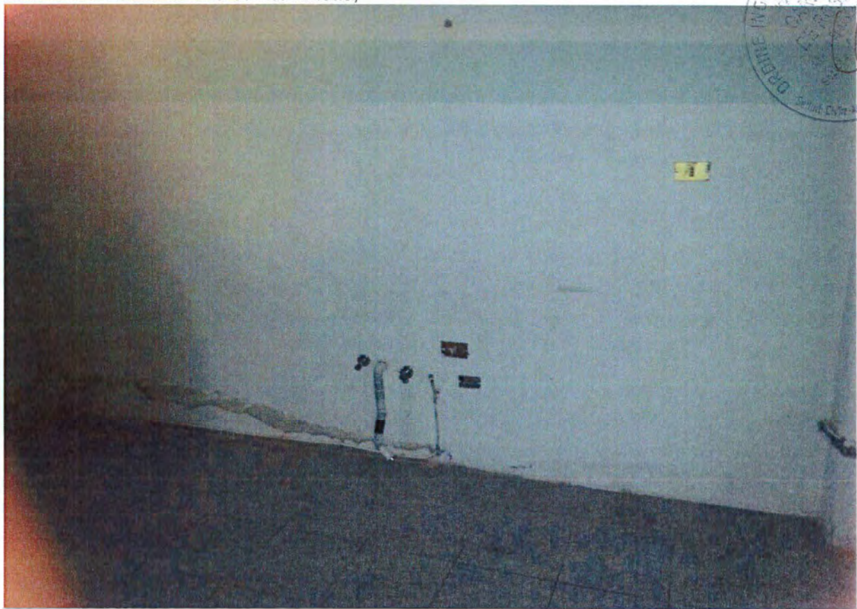
Foto n°16 :–Particolare parete cucina;
