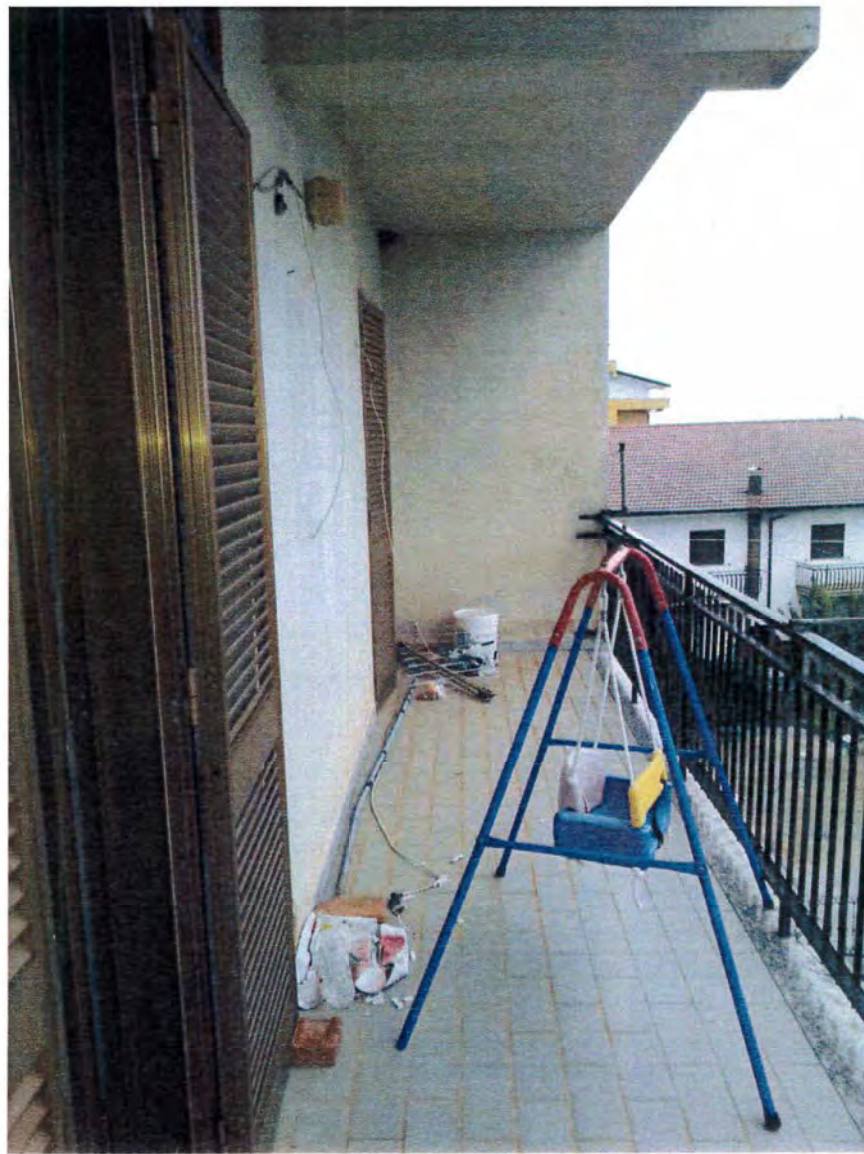
Foto n°12 :-Balcone sul prospetto a sud;
