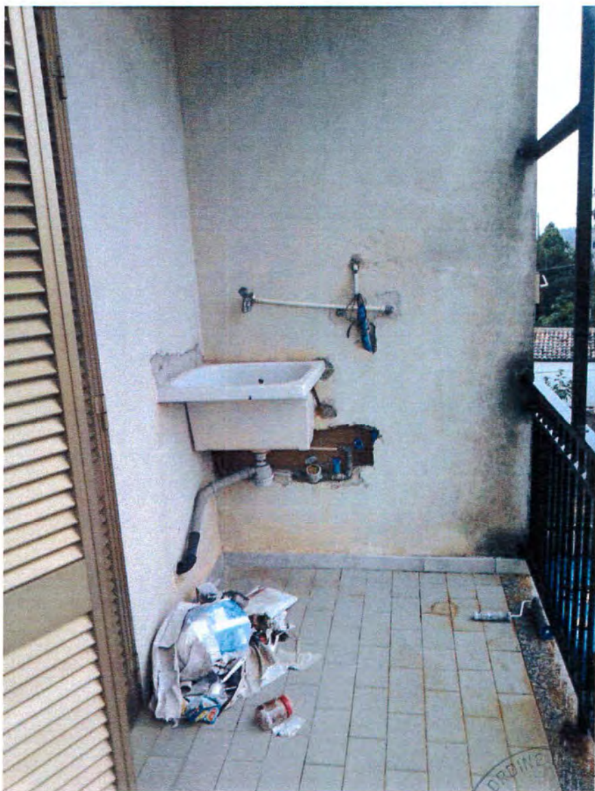
Foto n°13 :-Balcone sul prospetto ad Ovest;
