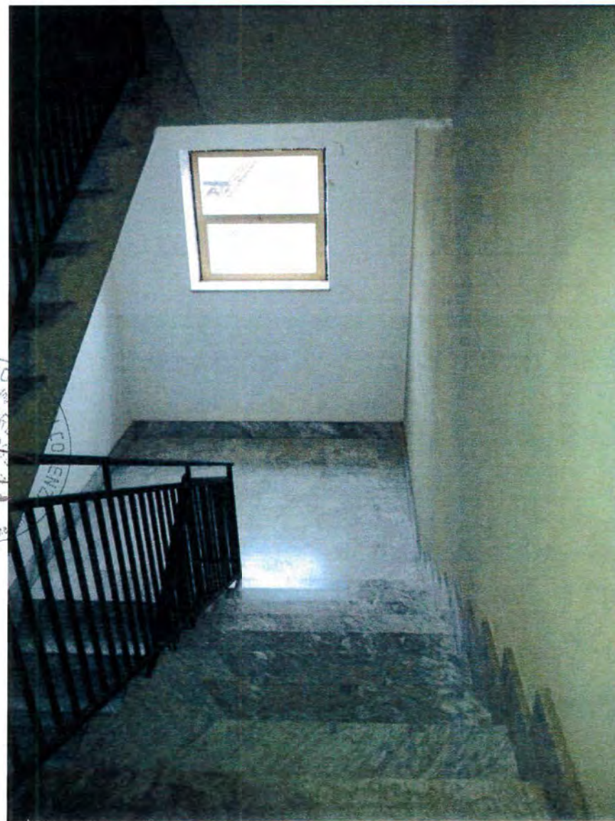
Foto n°2 :- Vano scala condominiale del fabbricato in Torano Castello (Sartano) (CS) al fg. n°13, p.lla n°820;
