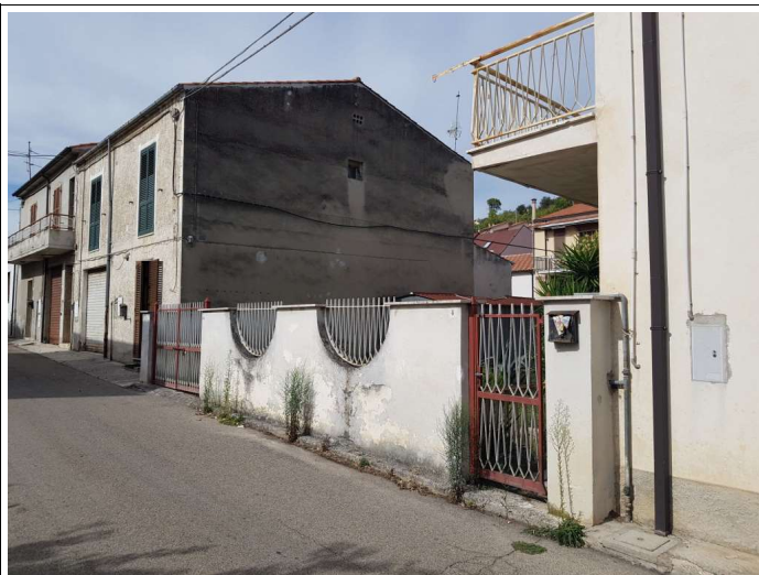
Foto 8) Edificio, Recinzione e Cortile Esterno – Recinzione con Accessi Carrabile e Pedonale su Via Gorizia
