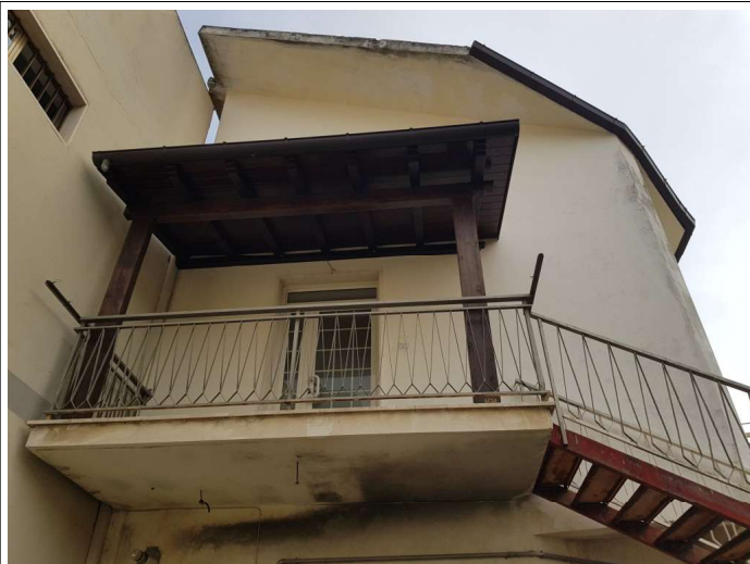
Foto 6) Edificio, Recinzione e Cortile Esterno – Prospetto su Cortile di Pertinenza – Accesso sul Retro Piano Primo
