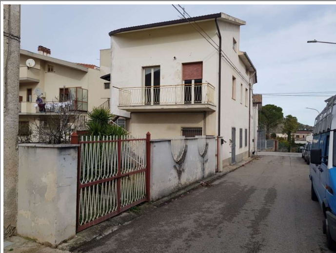
Foto 2) Edificio, Recinzione e Cortile Esterno – Prospetto su Via Gorizia
