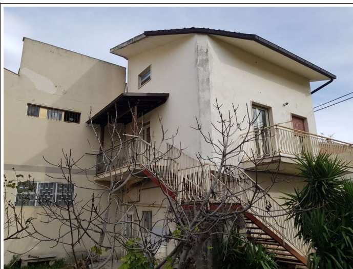
Foto 4) Edificio, Recinzione e Cortile Esterno – Prospetto su Cortile di Pertinenza
