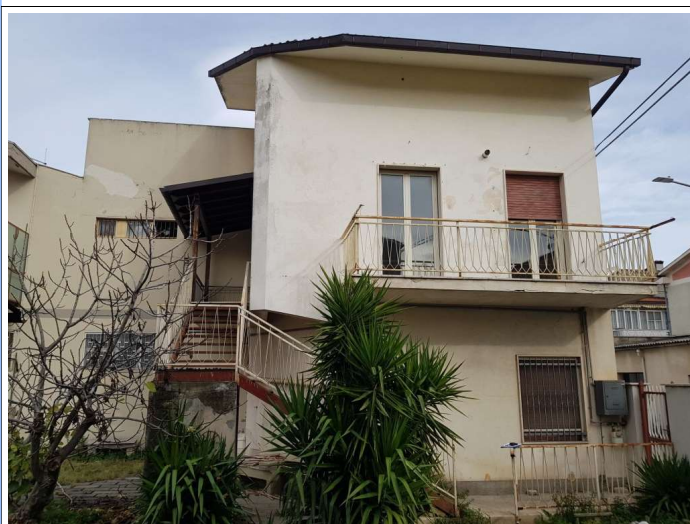
Foto 3) Edificio, Recinzione e Cortile Esterno – Prospetto su Cortile di Pertinenza
