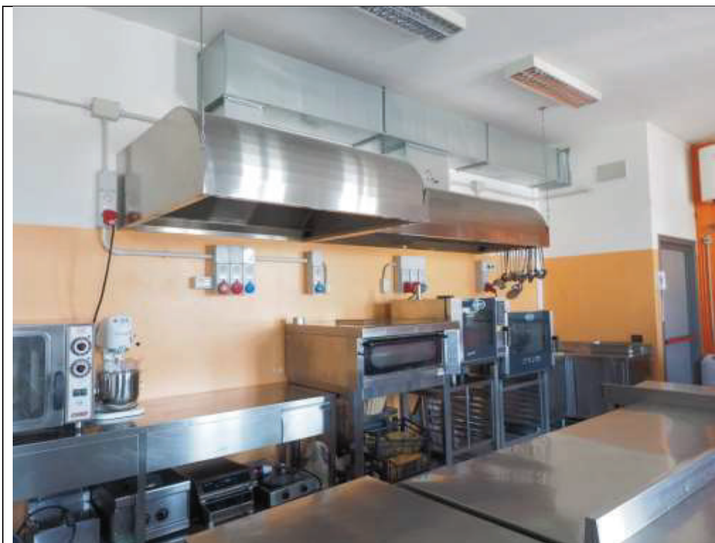
Figura 14 Aule e laboratori blocco A
