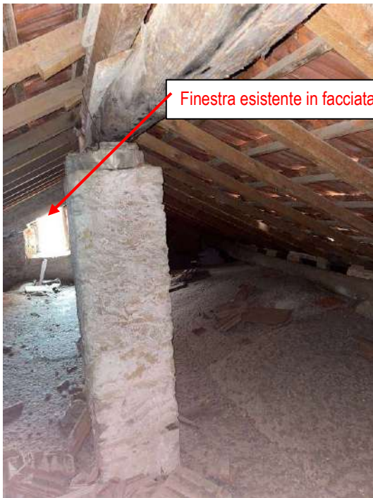
Foto 13: parte di sottotetto ispezionabile ma non utilizzabile (si vedano “ingombri” delle volte del piano sottostante) (scattate a giugno 2022)
