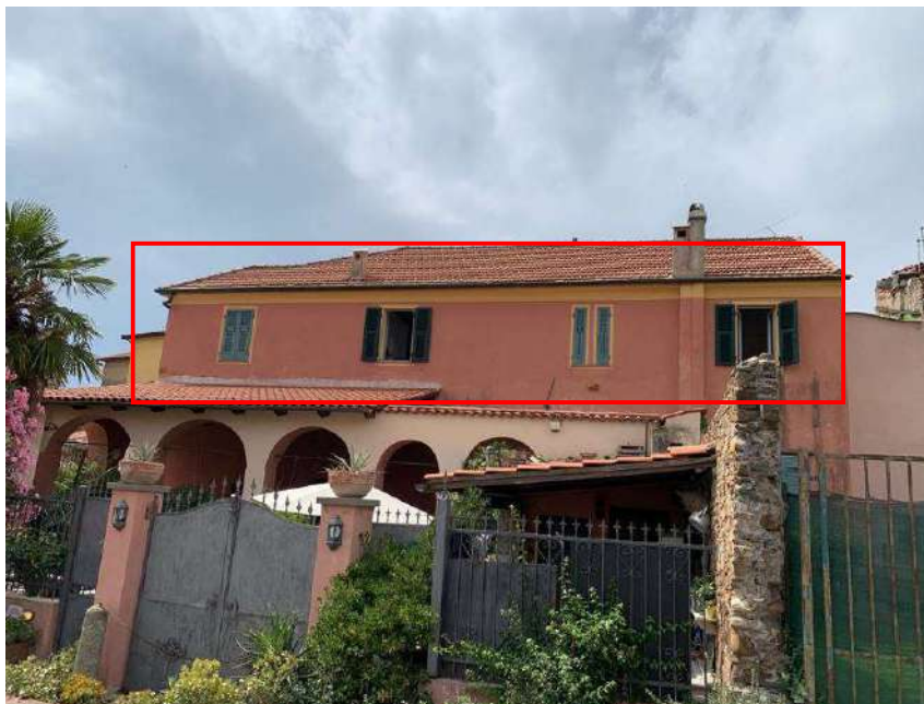
Foto 2: viste lato nord (lato pista ciclabile) finestre alloggio
