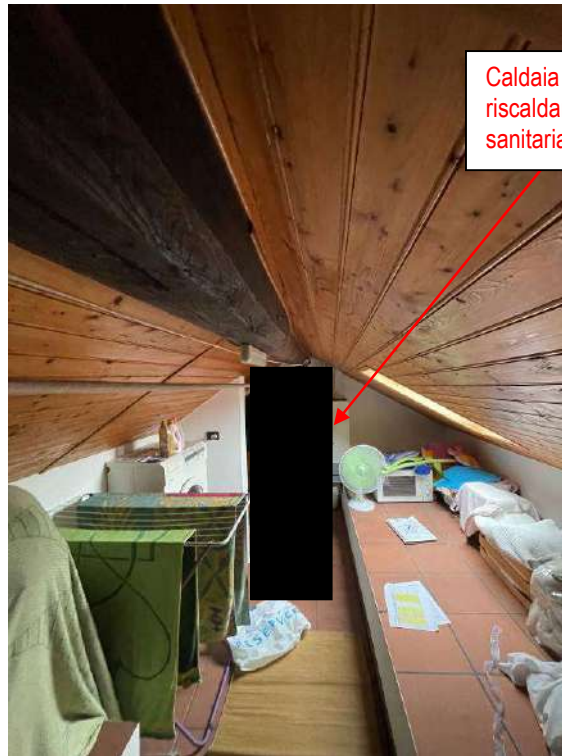
Foto 12: sottotetto/sgombero (scattate a giugno 2022)
