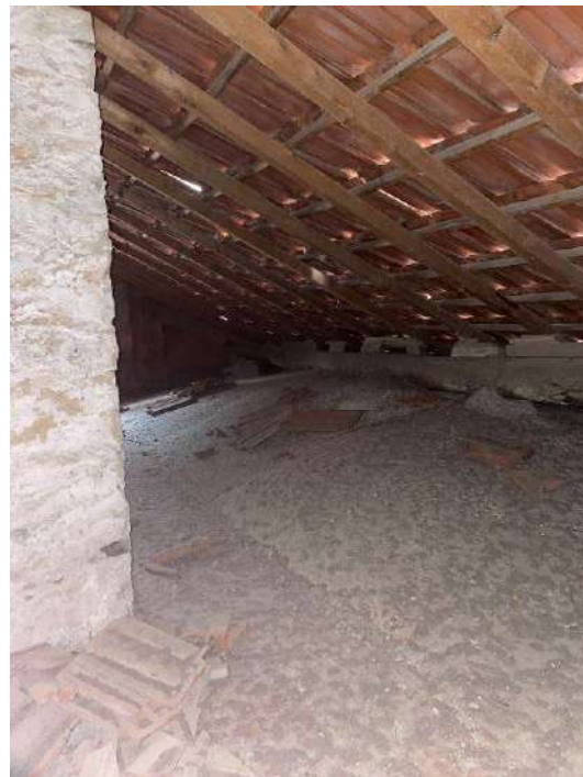
Foto 13: parte di sottotetto ispezionabile ma non utilizzabile (si vedano “ingombri” delle volte del piano sottostante) (scattate a giugno 2022)
