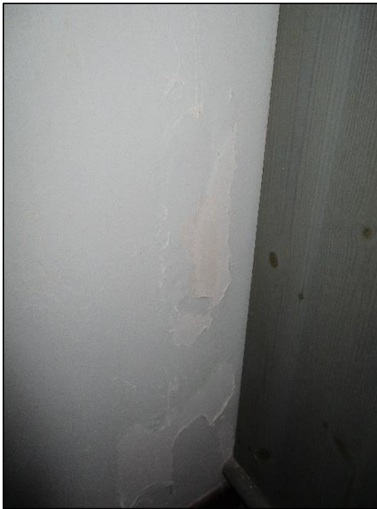
Foto 18 – Scrostamenti della tinteggiatura
