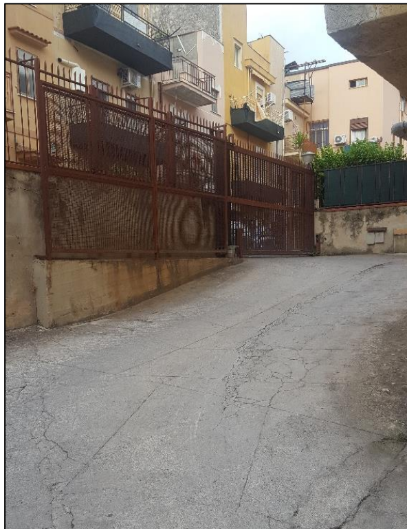
Foto 2 – Cannello di ingresso al locale cantina da via Monte Billiemi n. 2
