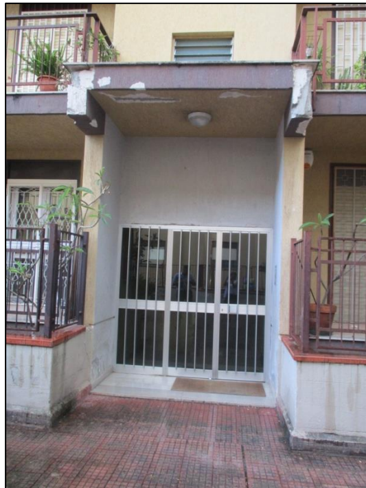
Foto 4 – Accesso alla scala B - Palazzina C
