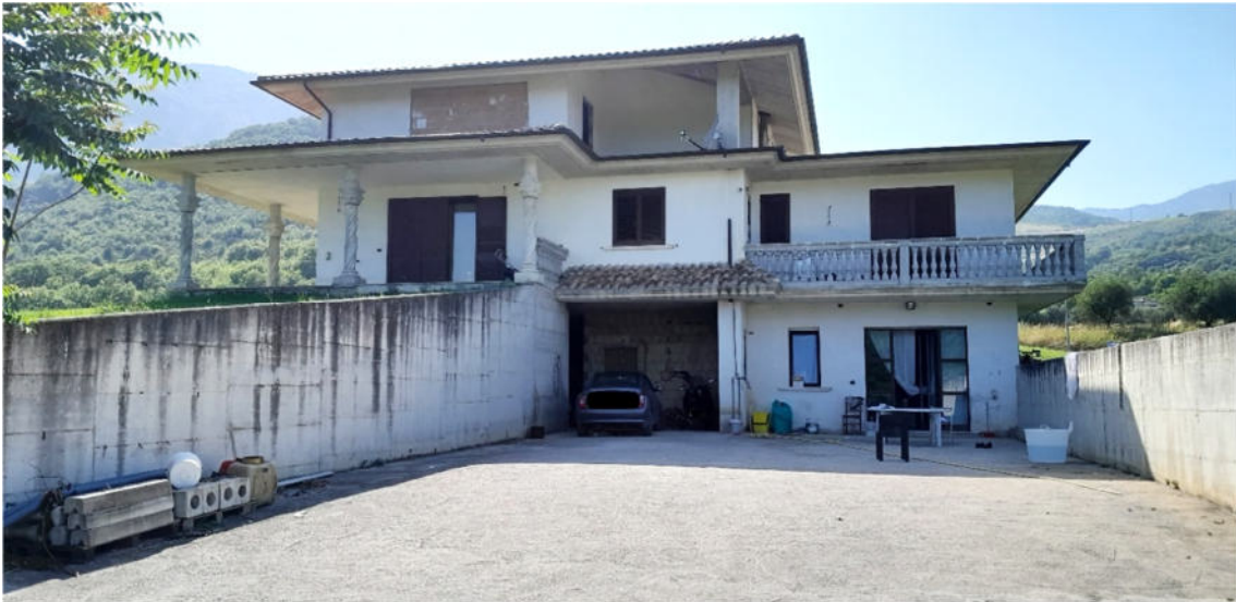
Vista dell'accesso al piano seminterrato - Prospetto lato Est
