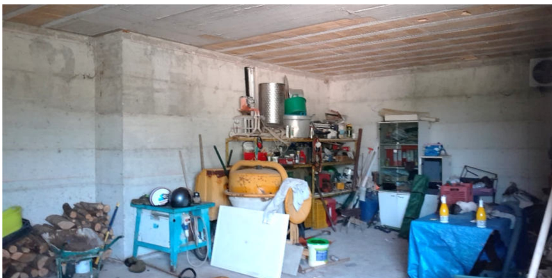
Vista interna del locale cantina in costruzione- Piano seminterrato (Bene n° 2)
