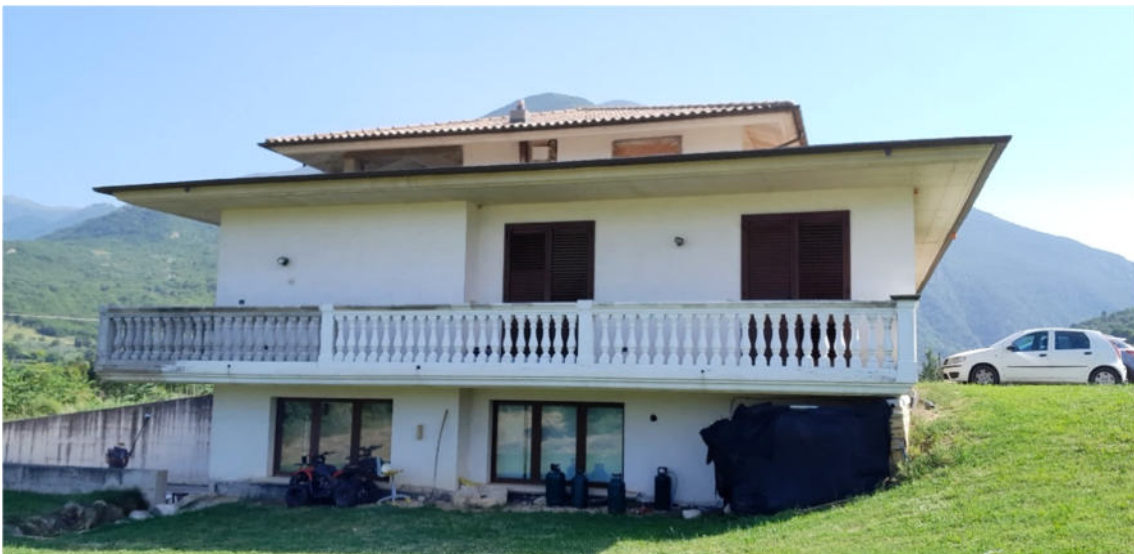
Vista del fabbricato - Prospetto lato Nord
