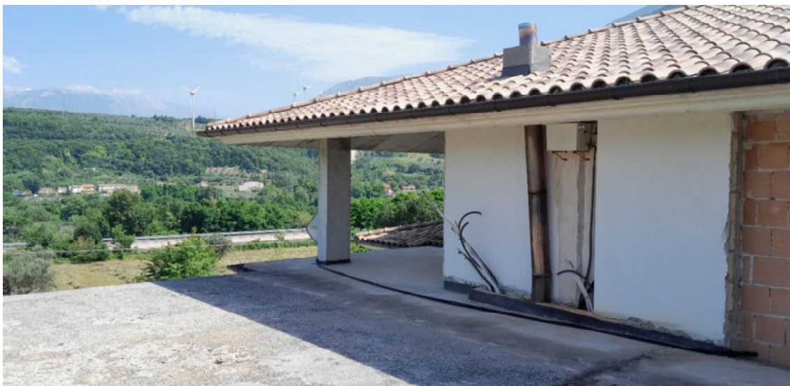
Viste esterne del locale sottotetto e terrazzi- Piano primo (Bene n°2)
