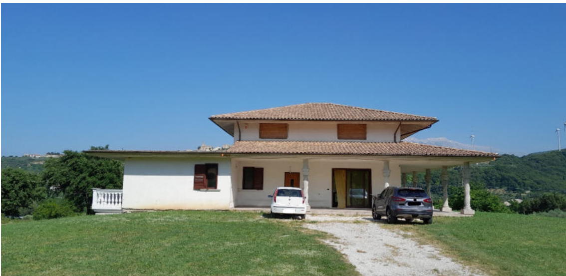
Prospetto principale - lato Ovest
