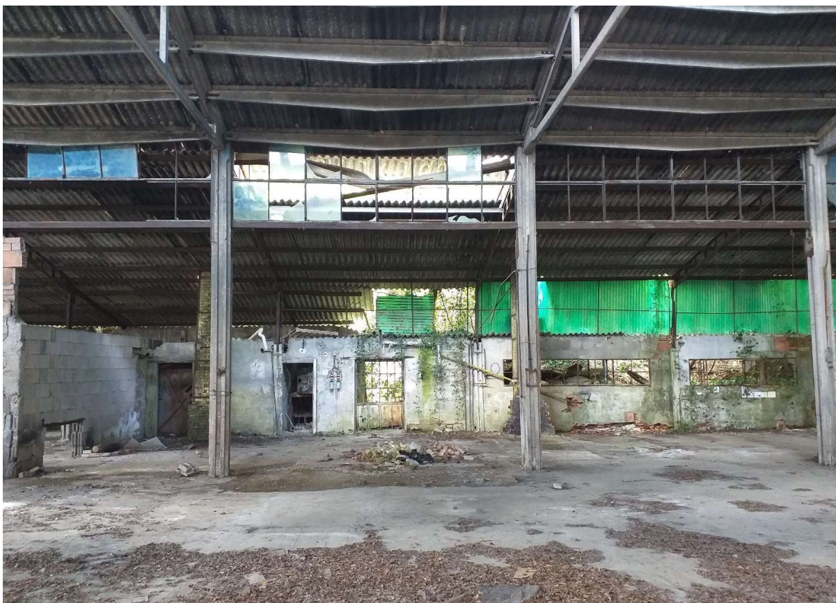
Panoramica interna area di lavorazione
