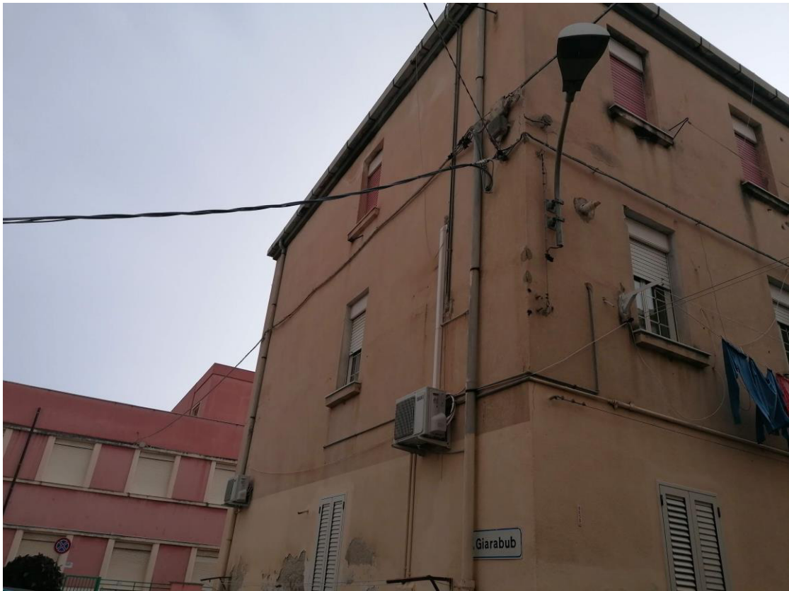
Foto n° 4 – Unità immobiliare al 2° piano del fabbricato sito in Gela nella via Monti 3. In Catasto al foglio 177 part.IIa 115 sub 6; Prospetto su via Giarabub
