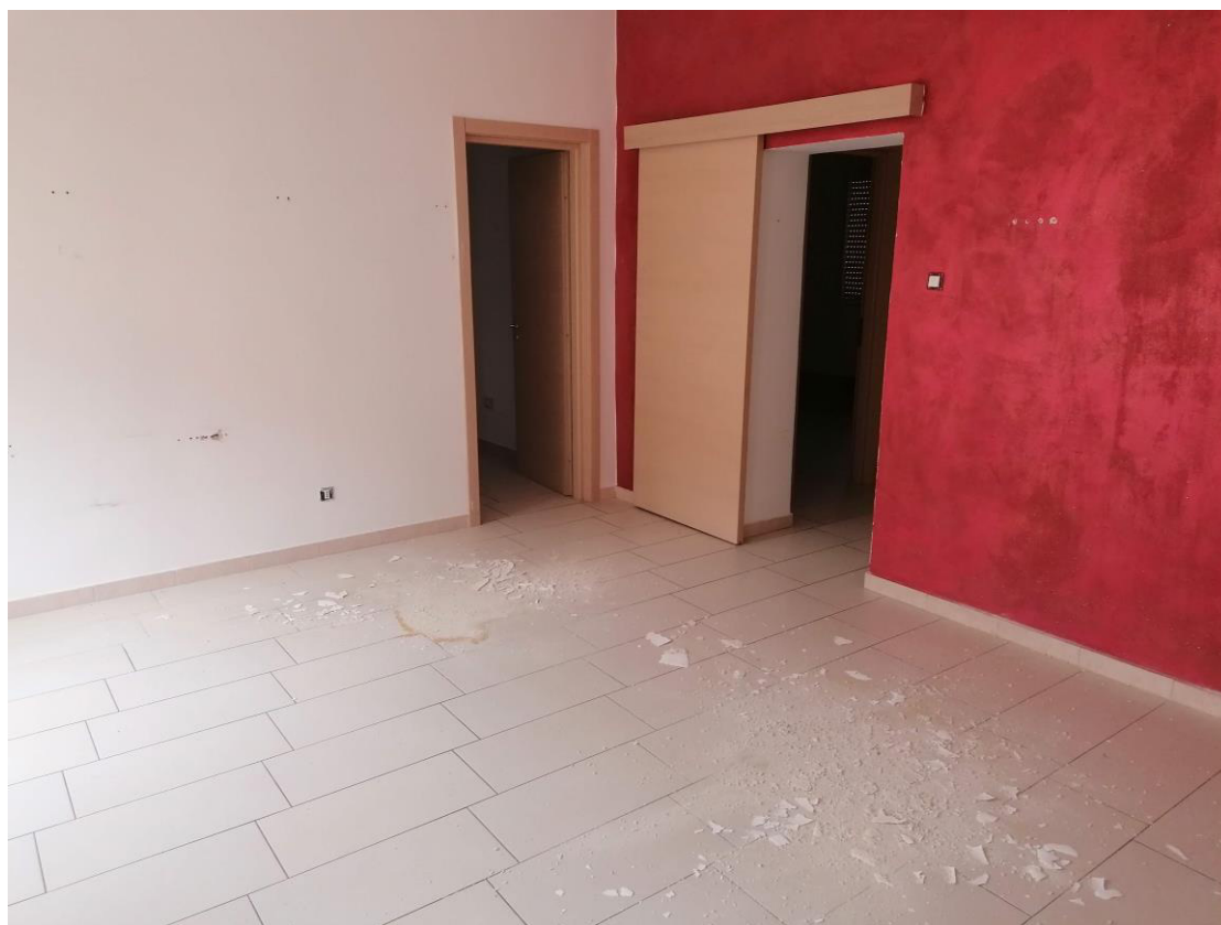
Foto n° 8 - Unità immobiliare al 2° piano del fabbricato sito in Gela nella via Monti 3. In Catasto al foglio 177 part.lla 115 sub 6; Soggiorno
