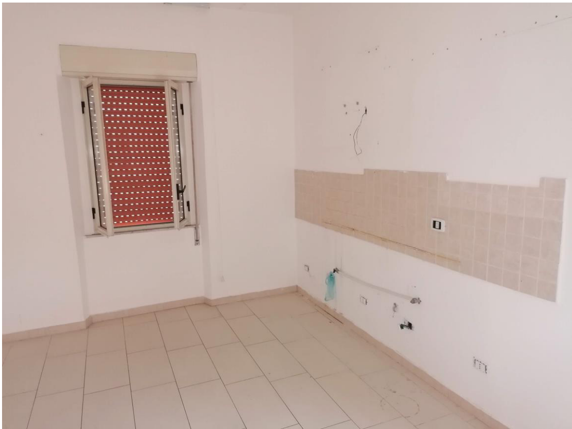
Foto n° 12 – Unità immobiliare al 2° piano del fabbricato sito in Gela nella via Monti 3. In Catasto al foglio 177 part.IIa 115 sub 6; Cucina
