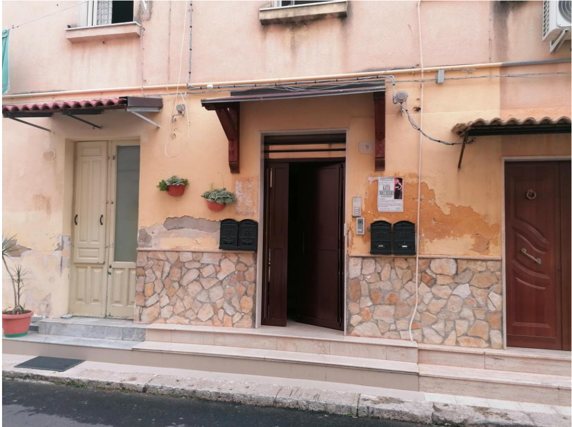
Foto n° 1 – Unità immobiliare al 2° piano del fabbricato sito in Gela nella via Monti 3. In Catasto al foglio 177 part.Illa 115 sub 6; Portone d'ingresso al fabbricato su via Monti.
