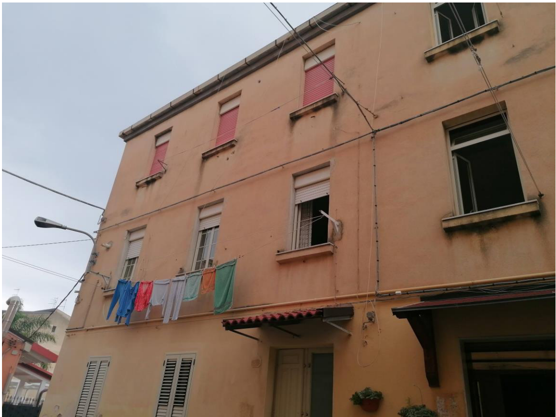
Foto n° 2 – Unità immobiliare al 2° piano del fabbricato sito in Gela nella via Monti 3. In Catasto al foglio 177 part.Illa 115 sub 6; Prospetto su via Monti
