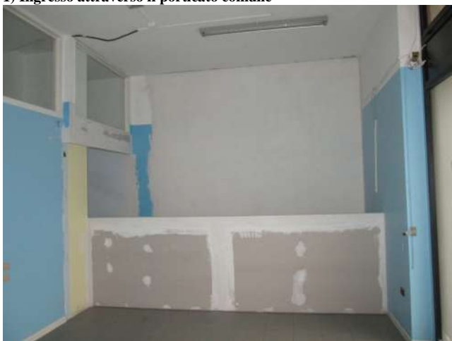
3) Locale di ingresso (alcune porzioni murarie realizzate in cartongesso)
