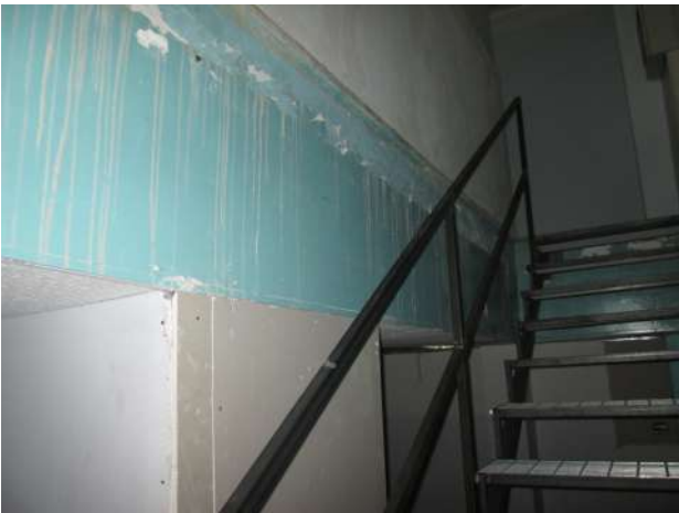
7) scala metallica di collegamento
