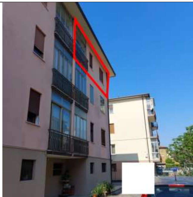
Foto 2: Vista del fabbricato dall'esterno: retro In rosso appartamento pignorato
