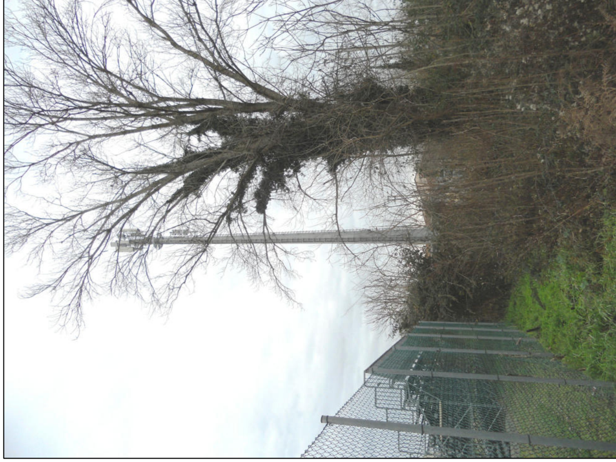
FOTO N°3 - VISTA DELLA STAZIONE RADIO PER TELECOMUNICAZIONI
