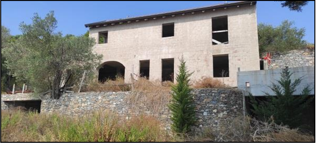
Foto n.1 – fabbricato lato mare
