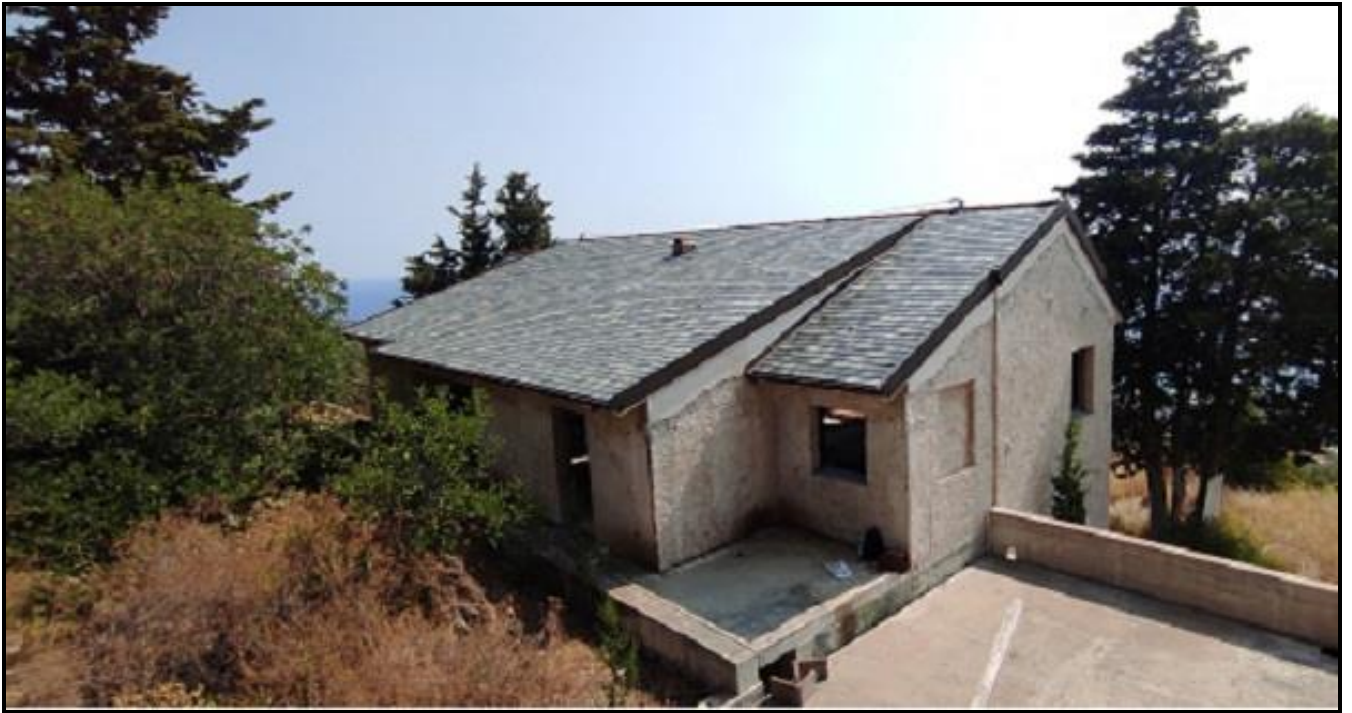
Foto n.3 – fabbricato corpo A – lato monte
