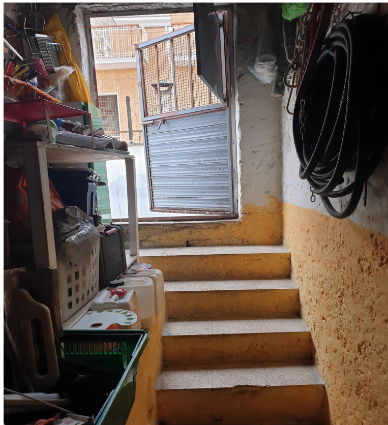
appartamento – scala vano secondo piano
