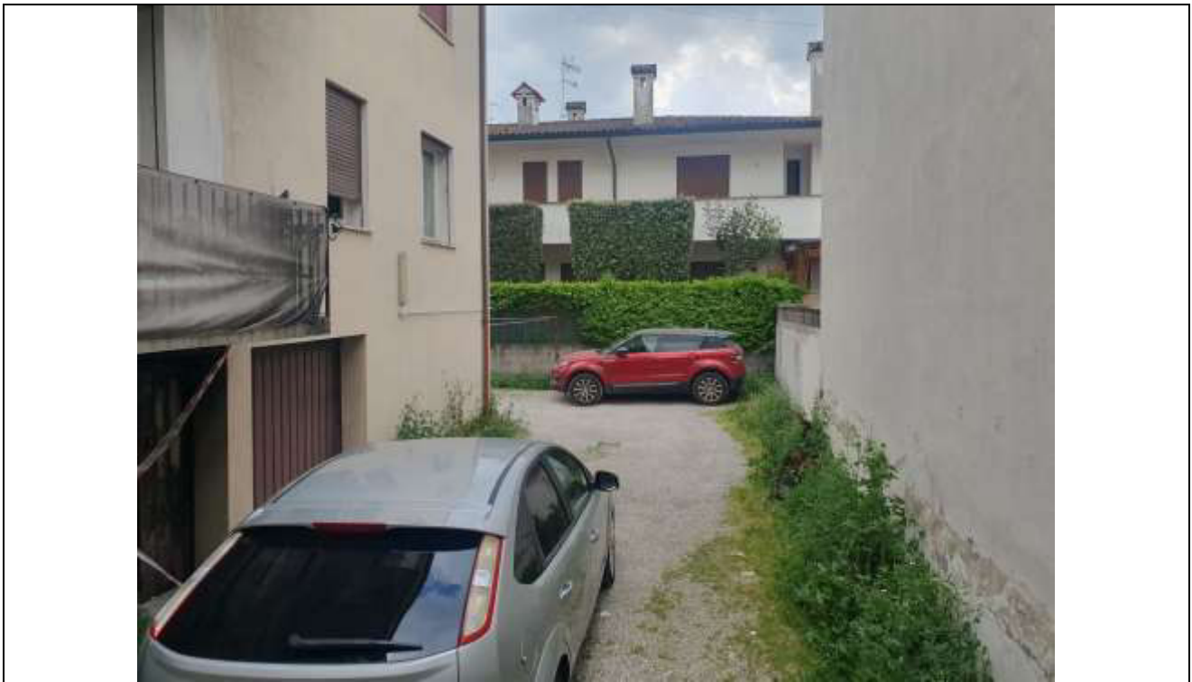
07 Vista dalla corte interna condominiale;
