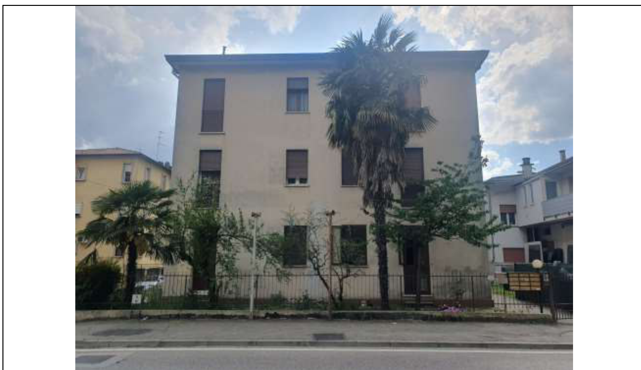
02 Vista del prospetto Nord del fabbricato condominiale;
