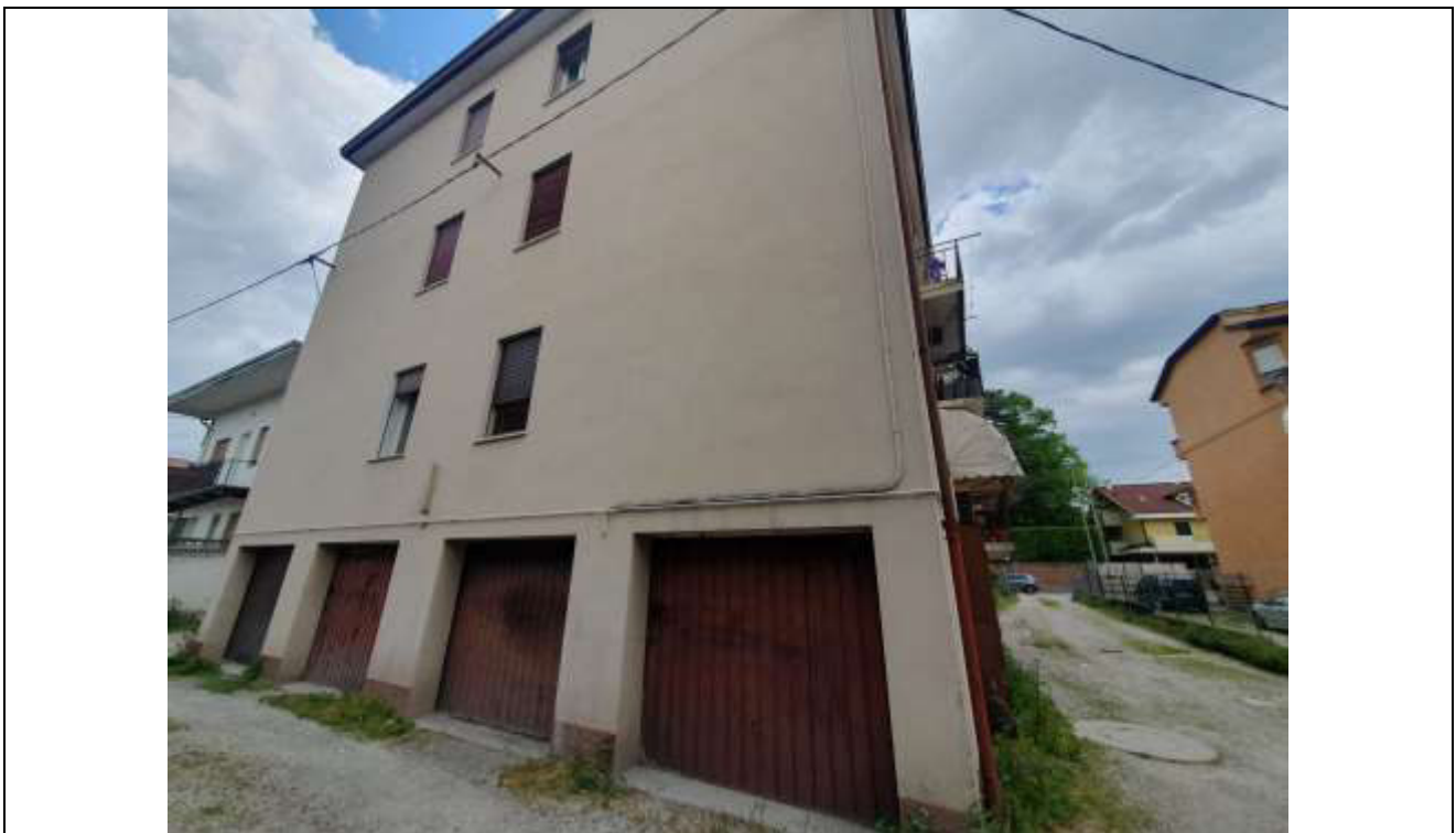
06 Vista dell'angolo Sud-Est del condominio;
