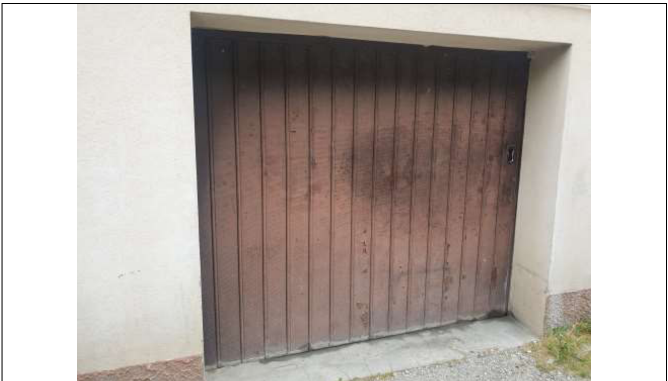
08 Vista dell'accesso dell'autorimessa oggetto di valutazione;
