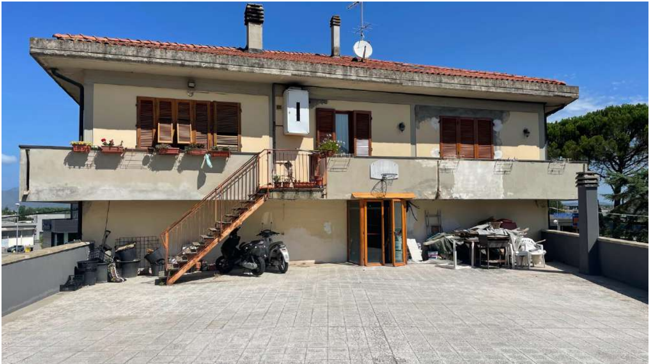
Lotto 3_U.I. 5/6_Facciata posteriore
