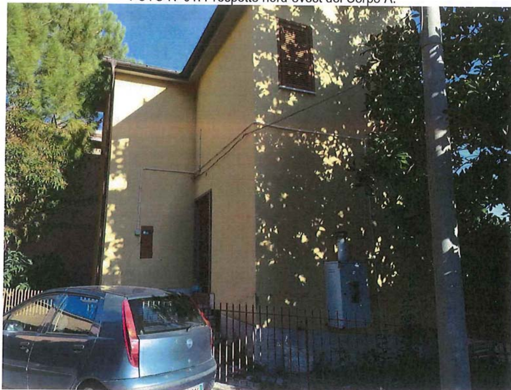
FOTO N°01: Prospetto nord-ovest del Corpo A.
