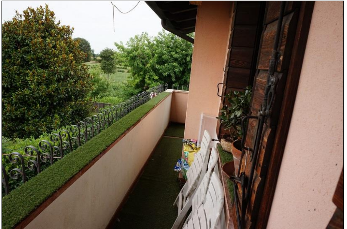
FOTO 49 – Piano primo: terrazza lato sud
