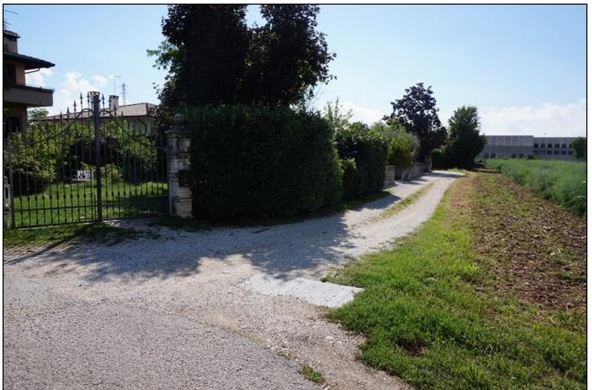
FOTO 58 – Lato ovest recintato Particella n.378 da nord/ovest
