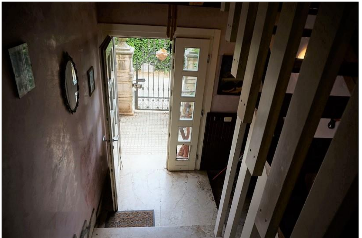
FOTO 12 – Ingresso comune fabbricato fronte nord
