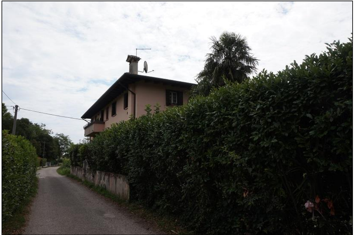
FOTO 3 – Vista da nord/ovest (da Via S. Marco)
