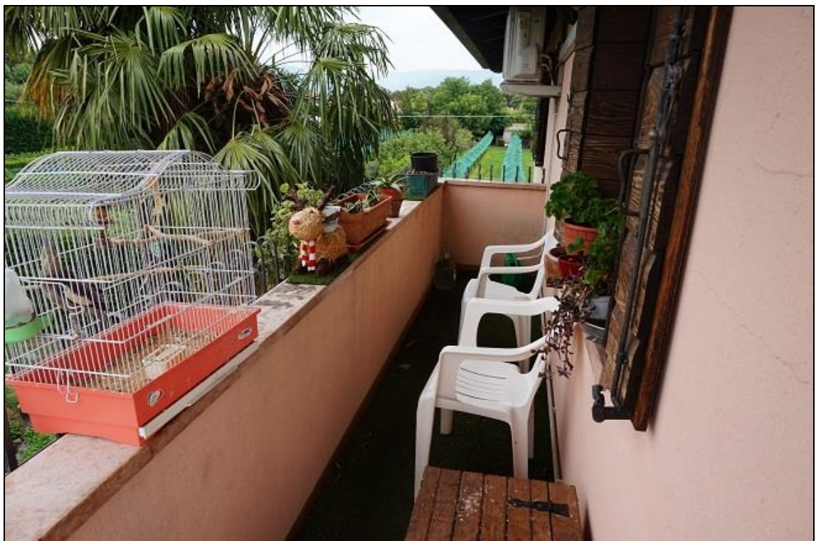
FOTO 50 – Piano primo: terrazza lato ovest
