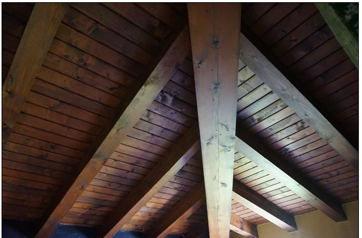
FOTO 56 – Piano primo: particolare tetto a vista
