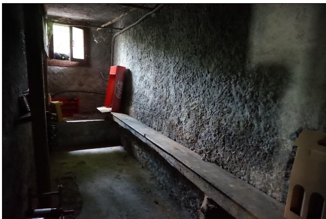
FOTO 40 – Piano seminterrato: cantina
