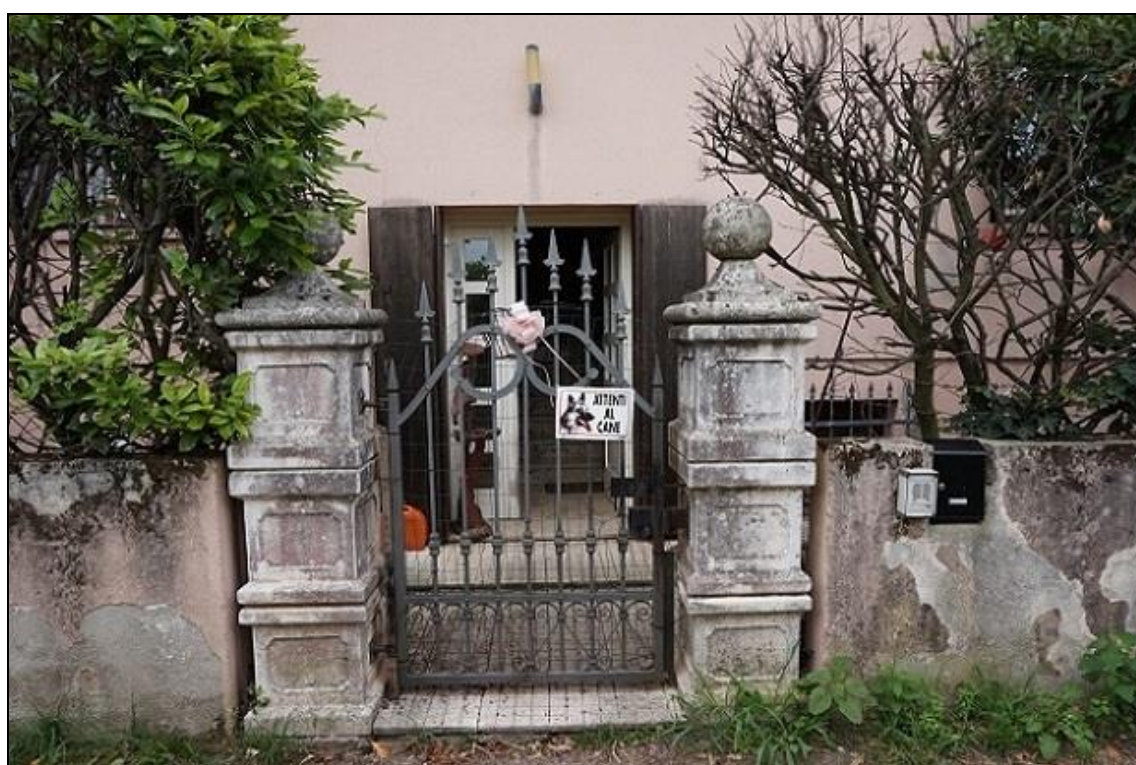
FOTO 2 – Accesso pedonale fronte nord
