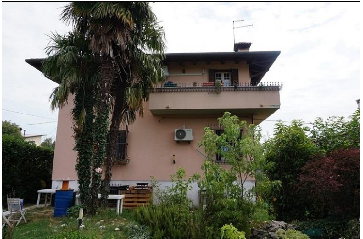
FOTO 7 – Fronte ovest da corte interna
