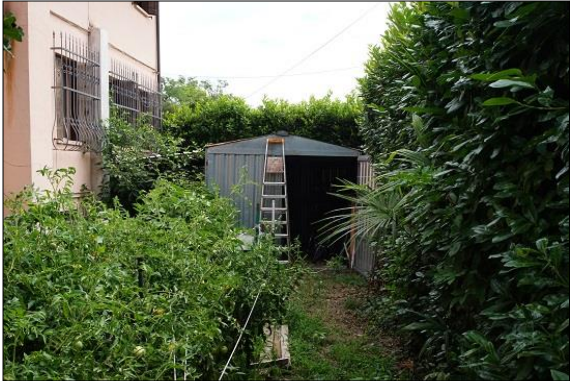
FOTO 9 – Fronte sud/est corte pertinenziale
