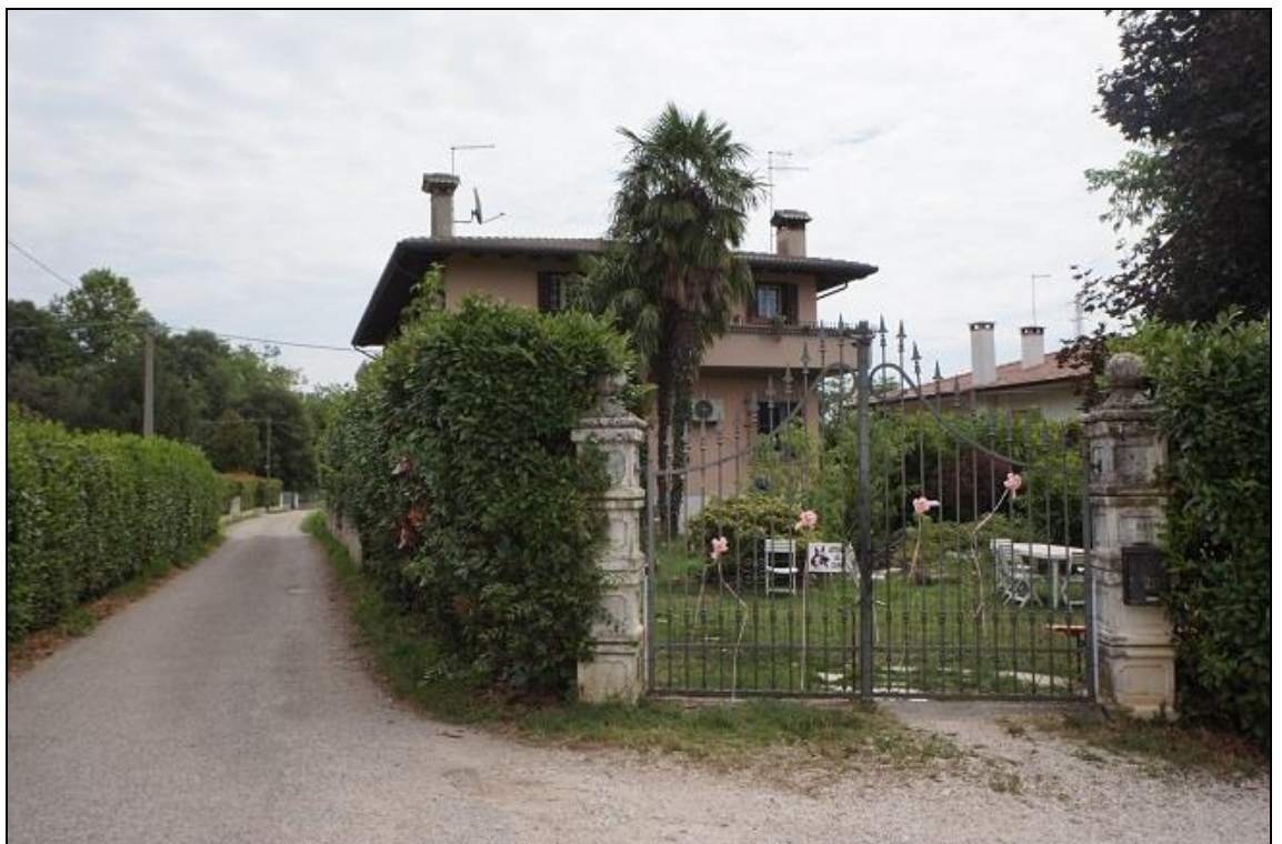
FOTO 4 – Vista da ovest
