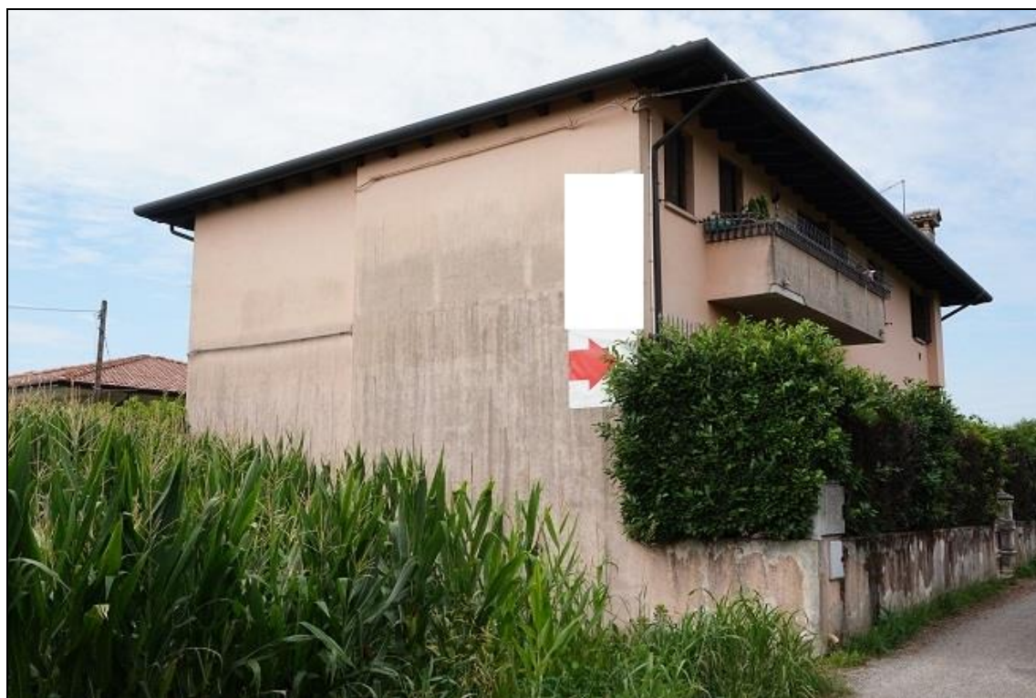
FOTO 1 – Vista da nord/est (da Via S. Marco)
