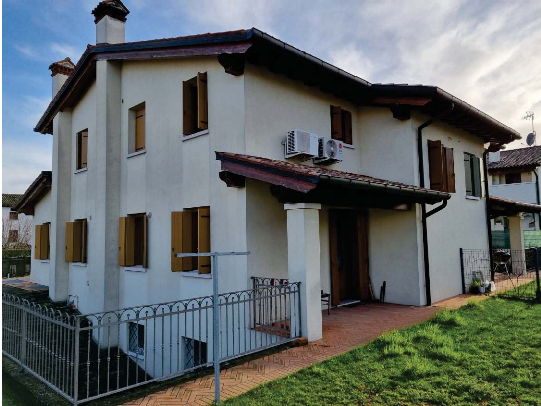
VISTA ESTERNA NORD/EST
