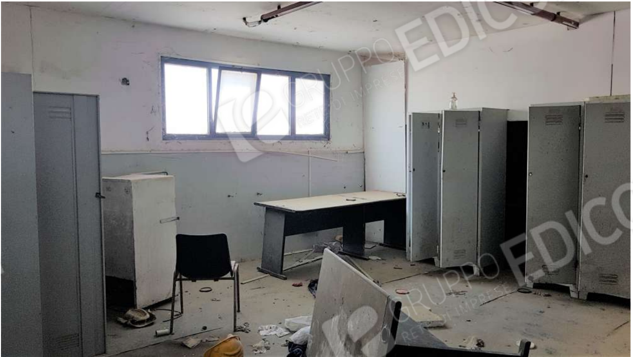
FOTO 7 vista interna zona spogliatoi
