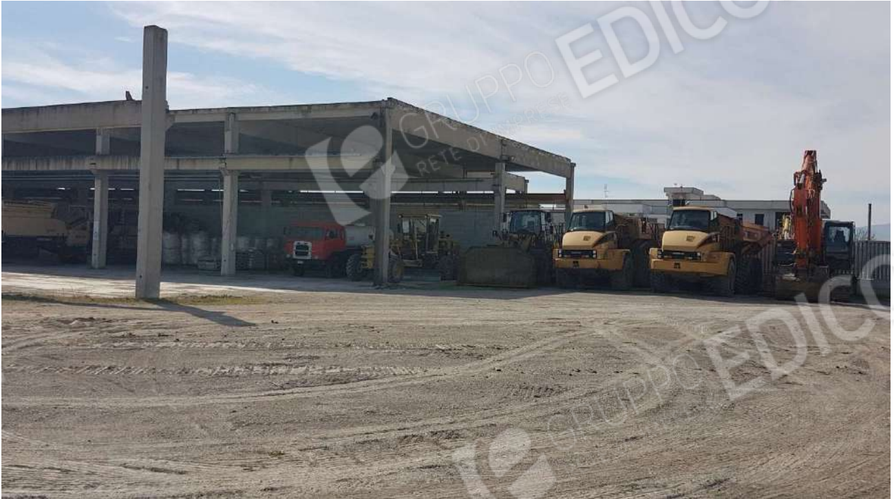
FOTO 11 vista tettoia (fg. 15-p.lla 204-sub.5) e pilastri carro ponte
