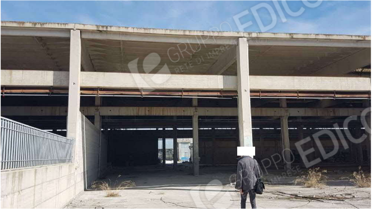
FOTO 10 vista tettoia annessa allo stabilimento
