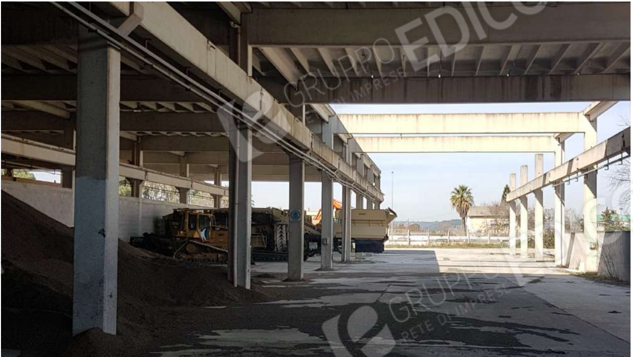
FOTO 13 vista dalla tettoia (fg. 15-p.la 204-sub.5) verso S.S. 106
