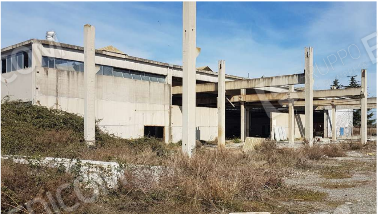
FOTO 2 vista area scoperta pilastri carroponete (fg. 15-p.lla 204-sub.3)
